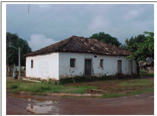
Fig. 34 e 35 - Construções em adobe e taipa, rebocadas
