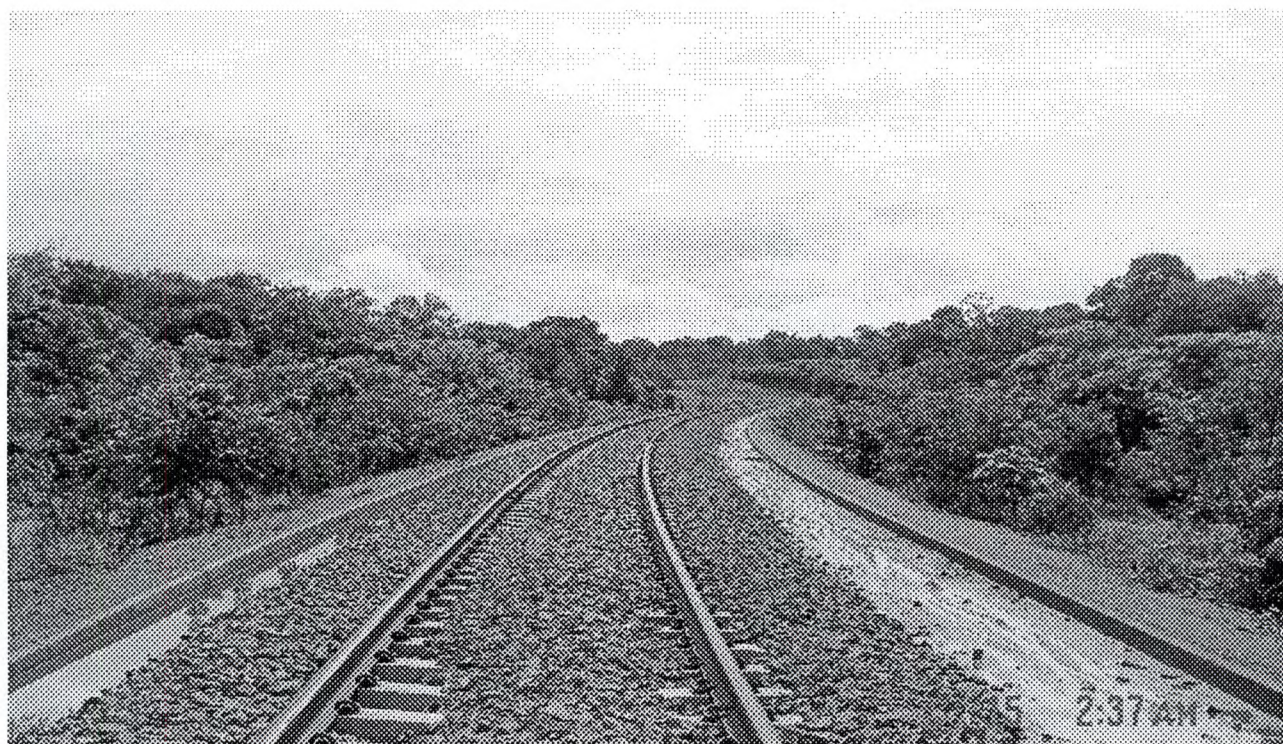
Trecho da Ferrovia Norte-Sul no Município de Palmeiras do Tocantins
