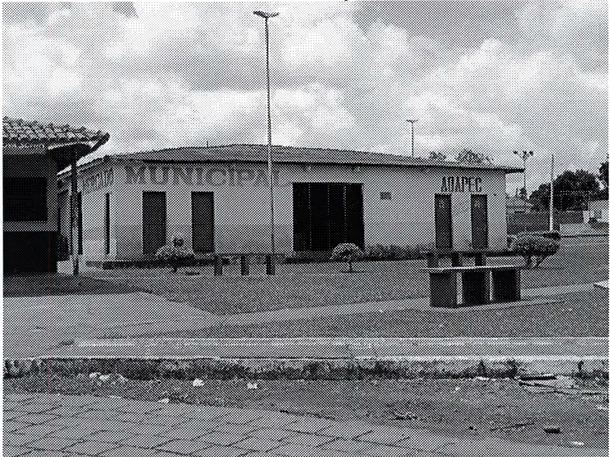
Figura 16: Vista do Mercado Público Municipal
