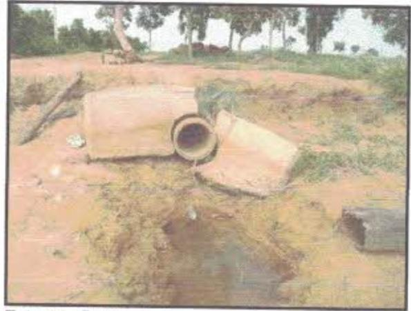
Foto 14. Ponto de lançamento sem dissipador de energia.
