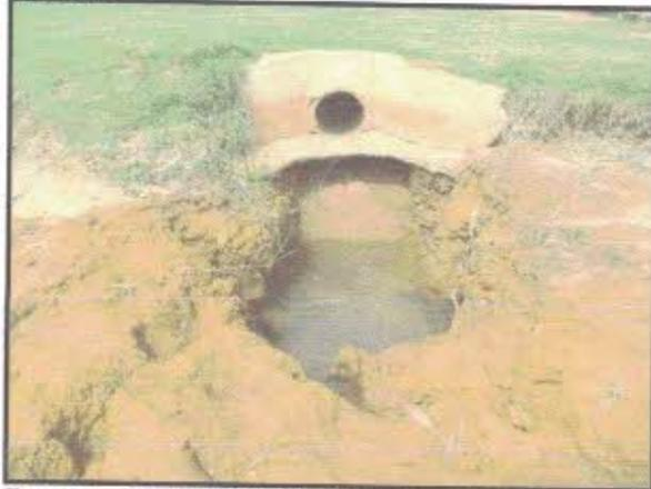
Foto 15. Outro ponto de lançamento sem dissipador de energia.
