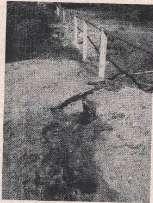
Figura 4: VAZAMENTO DO PV 2
