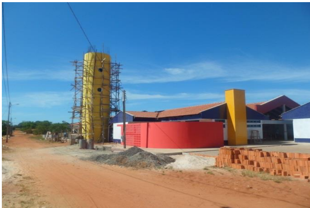
Fotografia 12: Creche em construção no Setor Monte Sinai – 2014
