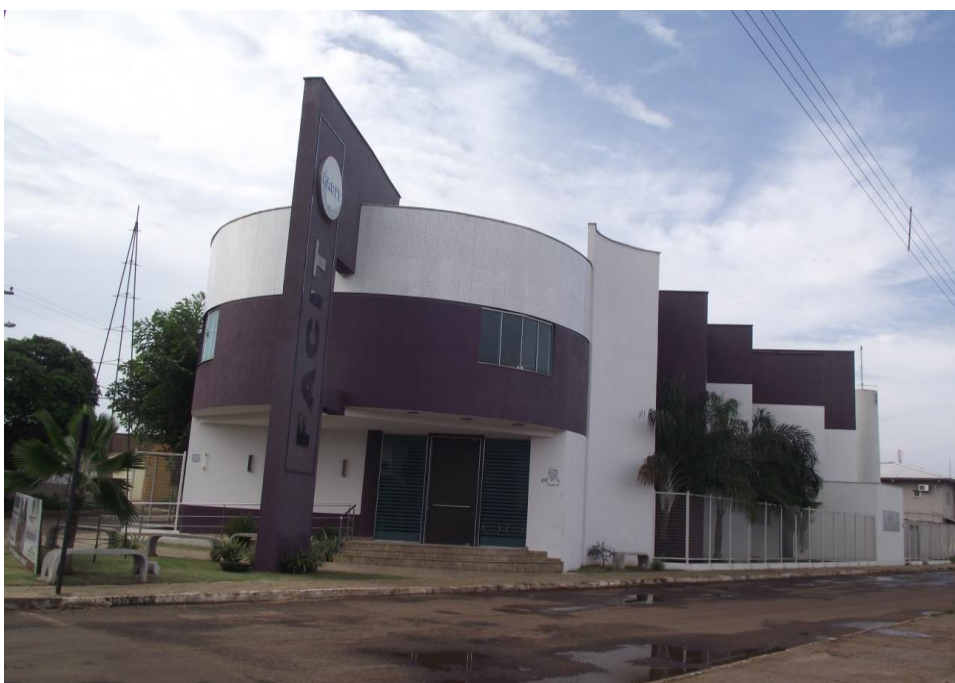
FIGURA 15 - Fachada da Faculdade FACIT, em Araguaína
