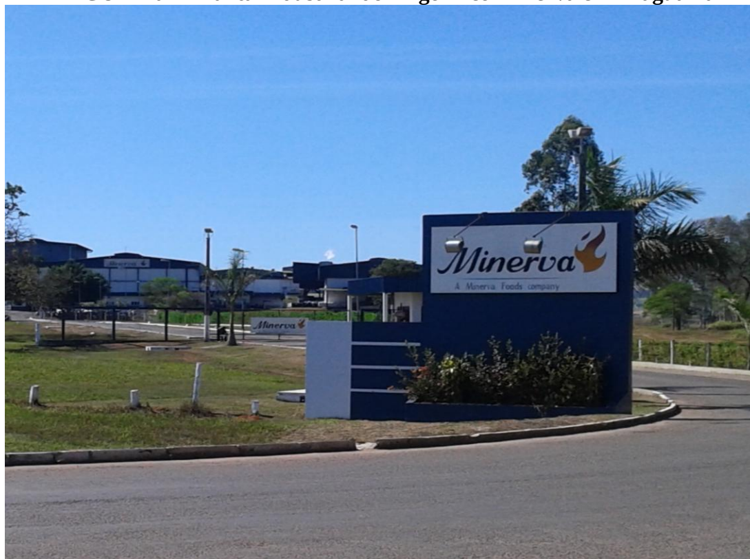
FIGURA 02 - Planta Industrial do Frigorífico Minerva em Araguaína
