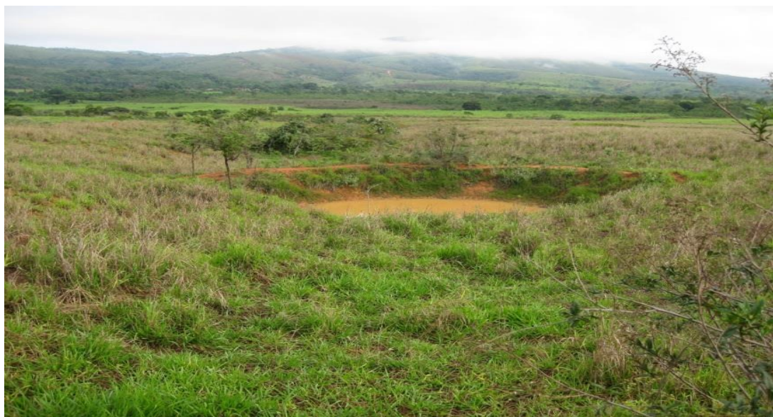
Figura 1 - Barraginha para controle de voçoroca
