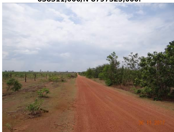
Figura 14: Aspecto geral da cobertura vegetal da área da Jazida 02 com acesso na Estaca 213 (LE), Coord. UTM 22L SIRGAS 2000 E-638115,000/N-8796770,000.
