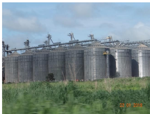
Figura 2: Silos verticais para armazenamento e beneficiamento de grãos
