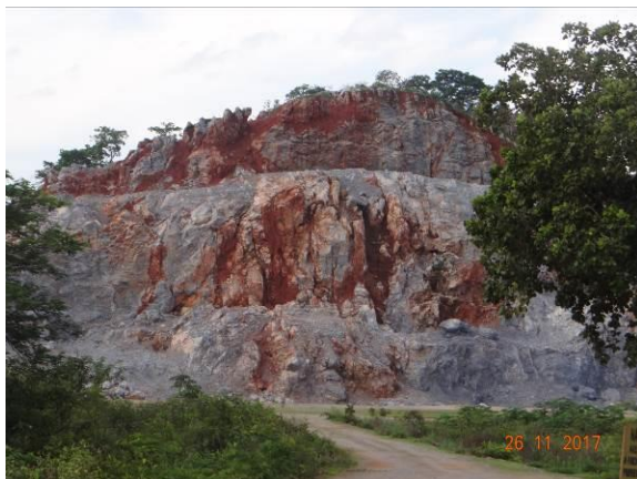
Figura 5: Aspecto da pedreira da empresa Pedreira Calcário Cristalândia localizada às margens da TO-374, Coord. UTM 22L SIRGAS 2000 E-649802,687/N-8801622,000.
