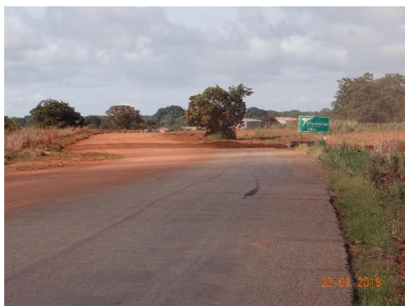
Figura 1: Início do trecho a ser pavimentado da TO-255 próximo à sede municipal
