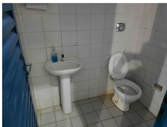
Foto 24 – VISTA DO REVESTIMENTO, PISO E LOUÇAS
