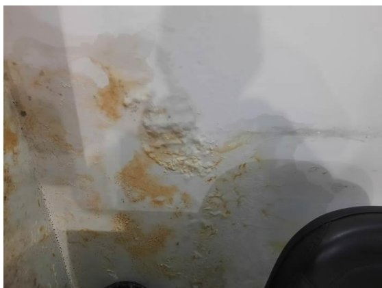
Foto 19 – INFILTRAÇÕES INTERNAS
