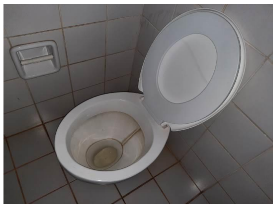
Foto 24 – VISTA DO VASO E PISO CERÂMICO
