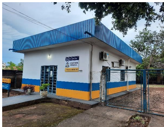
Foto 2 – VISTA PARCIAL EXTERNA
