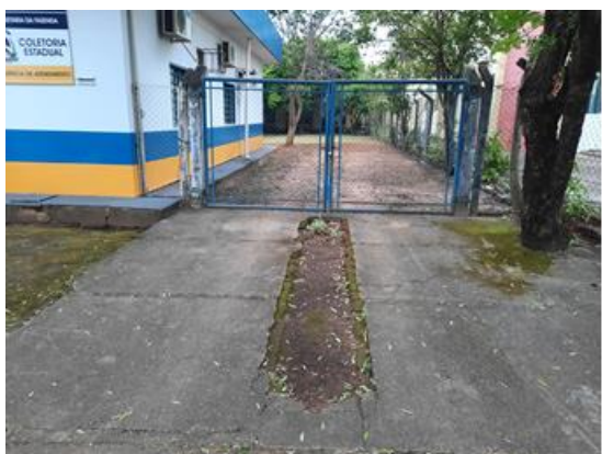
Foto 3 – VISTA DA ENTRADA - GARAGEM
