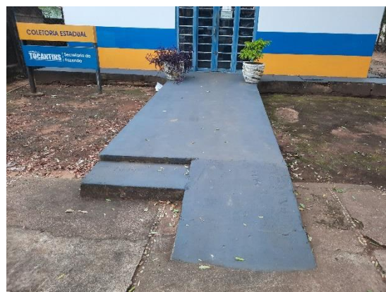
Foto 4 – RAMPA DE ACESSO
