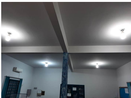
Foto 23 – VISTA PARCIAL DA PINTURA INTERNA
