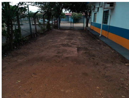
Foto 22 – GARAGEM IMPROVISADA SEM PISO E COBERTURA
