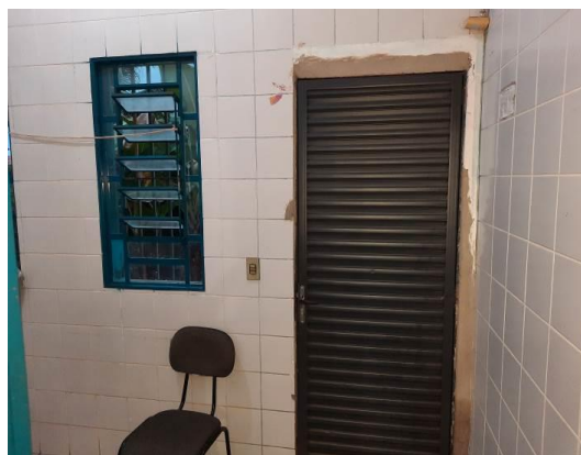
Foto 20 – PORTA SEM PROTEÇÃO DE PINTURA
