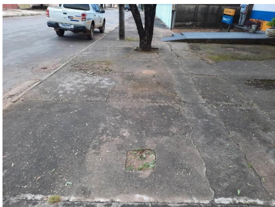
Foto 9 – CONCRETO DETERIORANDO
