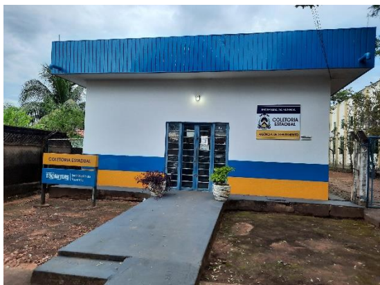
Foto 1 – FACHADA PRINCIPAL - COLETORIA
