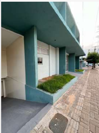
Imagem 03: Reforma e Adequação da Unacon Araguaína
