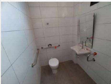
Imagem 16: Construção da Unacon-HGP
