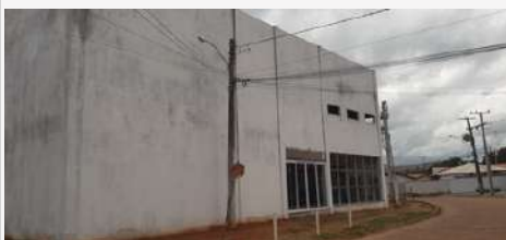
Imagem 6: Reforma e Ampliação do Hospital de Augustinópolis
