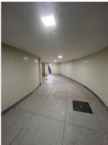
Imagem 04: Reforma e Adequação da Unacon Araguaína
