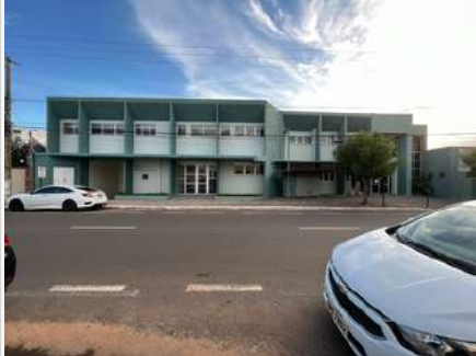
Imagem 01: Reforma e Adequação da Unacon Araguaína
