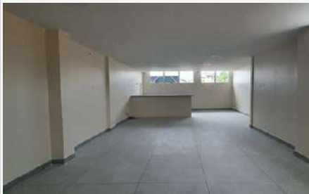
Imagem 02: Reforma e Adequação da Unacon Araguaína
