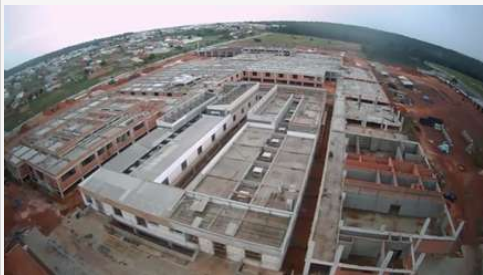
Imagem 17: Execução de Obra Hospital Geral de Araguaína - HGA
