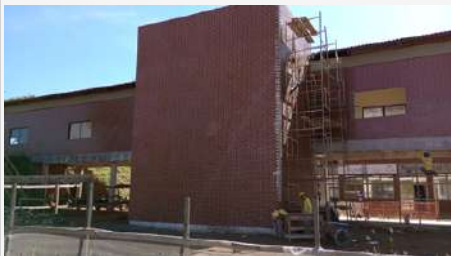
Imagem 10: Reforma e Ampliação do Hospital Geral de Palmas
