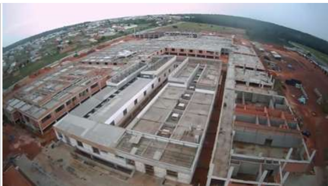
Imagem 01: Execução de Obra Hospital Geral de Araguaína - HGA
