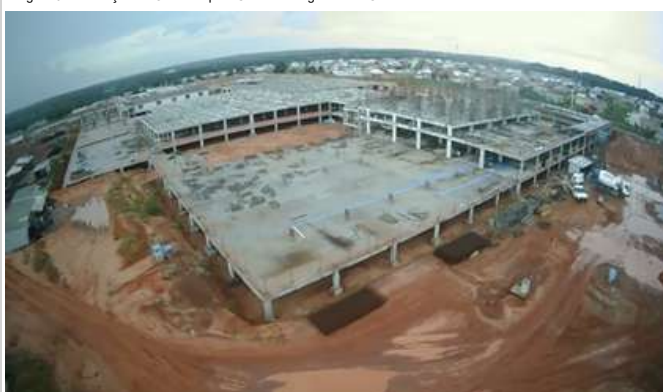
Imagem 02: Execução de Obra Hospital Geral de Araguaína - HGA
