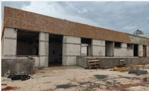
Imagem 19: Execução de Obra Hospital Geral de Araguaína - HGA
