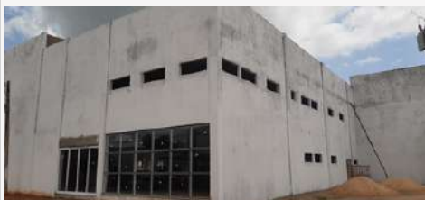
Imagem 5: Reforma e Ampliação do Hospital de Augustinópolis
