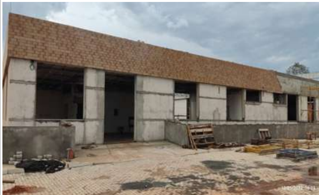
Imagem 03: Execução de Obra Hospital Geral de Araguaína - HGA
