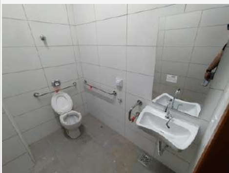
Imagem 15: Construção da Unacon-HGP
