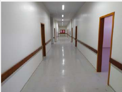
Imagem 13: Construção da Unacon-HGP
