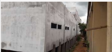
Imagem 7: Reforma e Ampliação do Hospital de Augustinópolis
