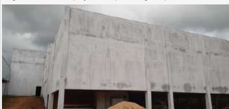
Imagem 8: Reforma e Ampliação do Hospital de Augustinópolis
