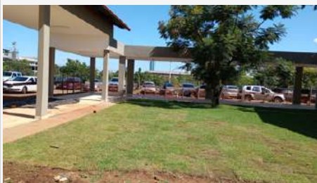
Imagem 12: Reforma e Ampliação do Hospital Geral de Palmas
