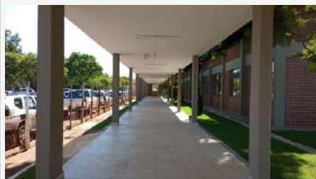
Imagem 11: Reforma e Ampliação do Hospital Geral de Palmas
