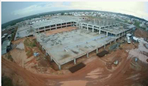
Imagem 18: Execução de Obra Hospital Geral de Araguaína - HGA
