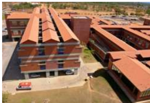
Início das Obras de Ampliação do HGPP
