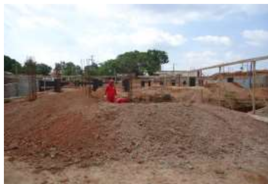
Obras iniciadas do HRAu
