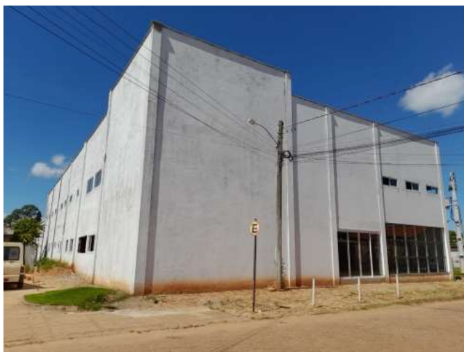
Imagem 03: Reforma e Ampliação do Hospital de Augustinópolis
