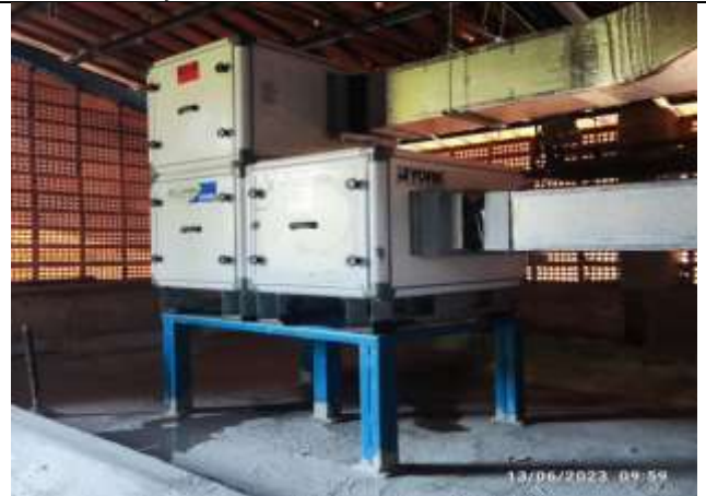
Faincoil pós reparos
