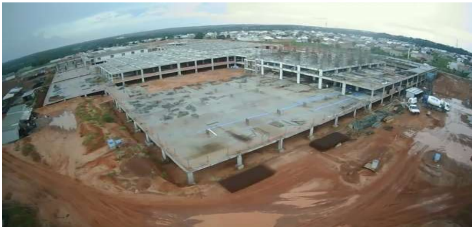
Imagem 02: Execução da Obra HGA
