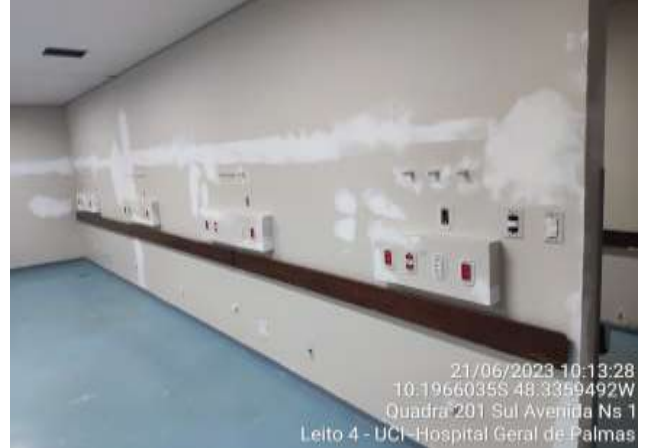
Adequação da UCI no subsolo - serviços de pintura, substituição de luminárias e tomadas, entre outros.
