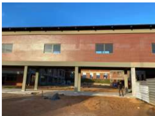
Imagem 04: Reforma e Ampliação do HGP
