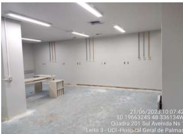
Adequação da UCI no subsolo - serviços de pintura, substituição de luminárias e tomadas, entre outros.
