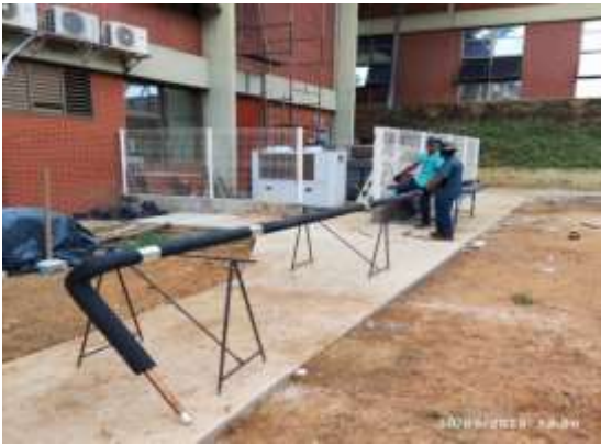
Manutenção do Faincoil: reparos e manutenção no Fain coil responsável pela refrigeração da Sala da Ressonância Magnética, como complemento necessário para a eficiência da instalação do novo chiller.
