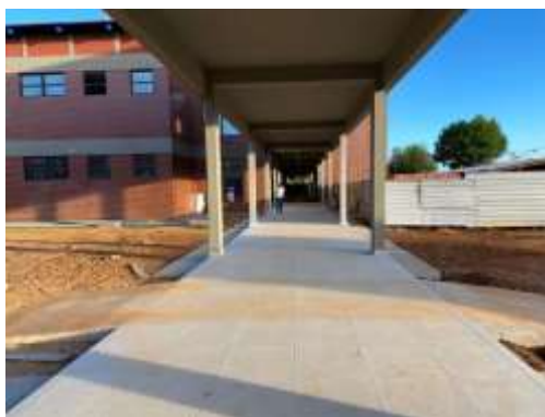
Imagem 05: Reforma e Ampliação do HGP
