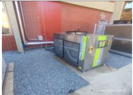
Manutenção do Faincoil: reparos e manutenção no Fain coil responsável pela refrigeração da Sala da Ressonância Magnética, como complemento necessário para a eficiência da instalação do novo chiller.
