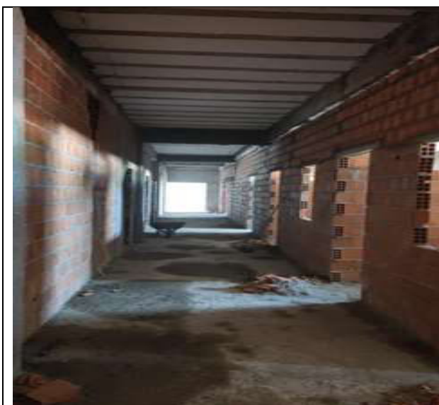
Reforma e Ampliação do Hospital de Augustinópolis
