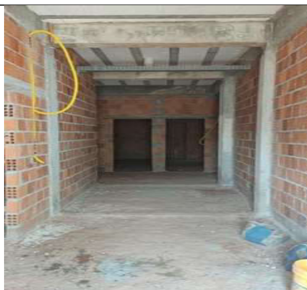
Reforma e Ampliação do Hospital de Augustinópolis
