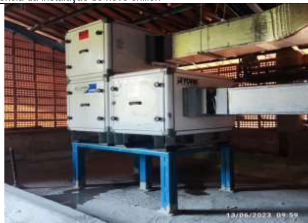
Faincoil pós reparos
