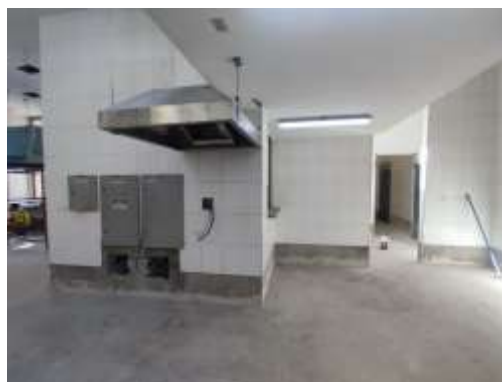
Imagem 14: Reforma e Ampliação do HGP – Salão principal da cozinha.
