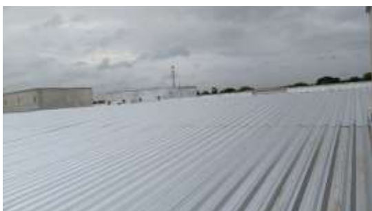
Imagem 09: Cobertura metálica do bloco da maternidade.
