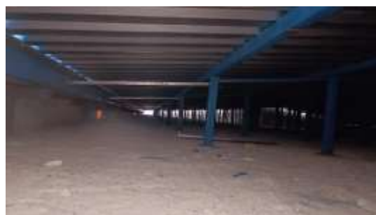
Imagem 10: Cobertura metálica do bloco da maternidade.
