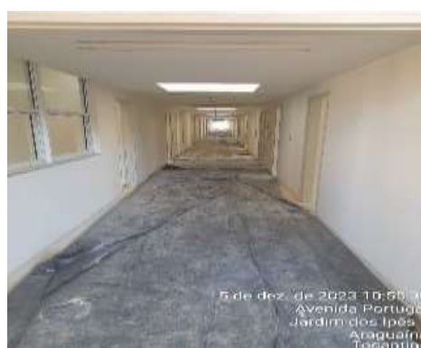
Imagem 03: Execução da Obra HGA – Circulação principal do bloco do ambulatório.
