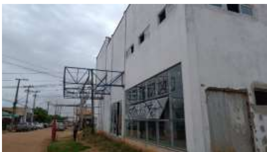
Imagem 07: Fachada do bloco da maternidade – instalação da marquise em estrutura metálica.
