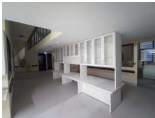
Imagem 12: Reforma e Ampliação do HGP – Posto de enfermagem dos 30 novos Leitos de UTI.
