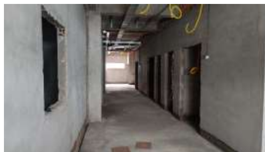
Imagem 08: Circulação interna do bloco da maternidade.
