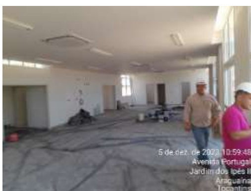
Imagem 02: Execução da Obra HGA – Recepção do bloco do ambulatório.
