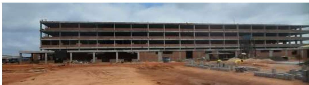
Imagem 06: Execução da Obra HGA – Fachada do bloco da internação.
