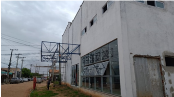
Imagem 07: Fachada do bloco da maternidade – instalação da marquise em estrutura metálica.
