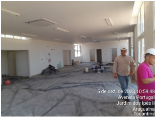
Imagem 02: Execução da Obra HGA – Recepção do bloco do ambulatório.
