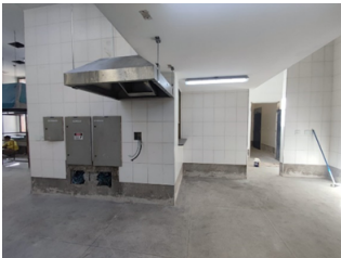
Imagem 14: Reforma e Ampliação do HGP – Salão principal da cozinha.
