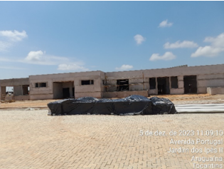
Imagem 04: Execução da Obra HGA – Fachada do bloco do Pronto Socorro.
