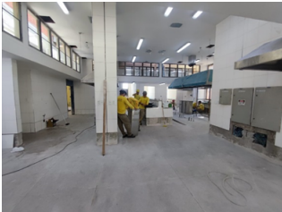
Imagem 13: Reforma e Ampliação do HGP – Salão principal da cozinha.
