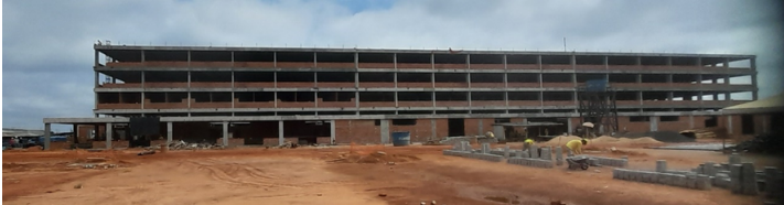
Imagem 06: Execução da Obra HGA – Fachada do bloco da internação.
