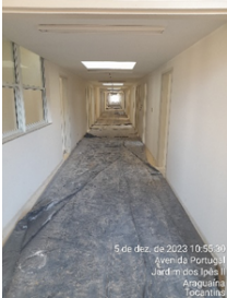
Imagem 03: Execução da Obra HGA – Circulação principal do bloco do ambulatório.
