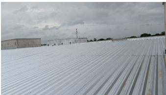
Imagem 09: Cobertura metálica do bloco da maternidade.
