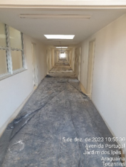
Imagem 03: Execução da Obra HGA – Circulação principal do bloco do ambulatório.
