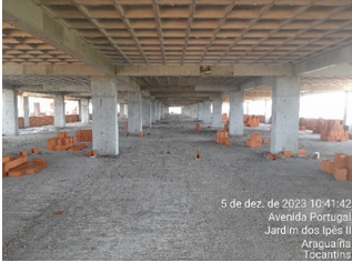
Imagem 05: Execução da Obra HGA – 2º Pavimento do bloco da internação.
