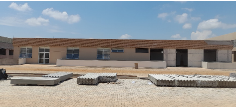
Imagem 01: Execução da Obra HGA – Fachada do bloco do ambulatório.
