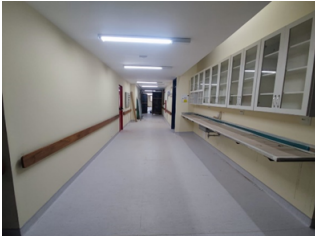
Imagem 11: Reforma e Ampliação do HGP – Circulação dos 30 novos Leitos de UTI.
