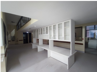
Imagem 12: Reforma e Ampliação do HGP – Posto de enfermagem dos 30 novos Leitos de UTI.
