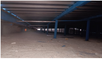
Imagem 10: Cobertura metálica do bloco da maternidade.
