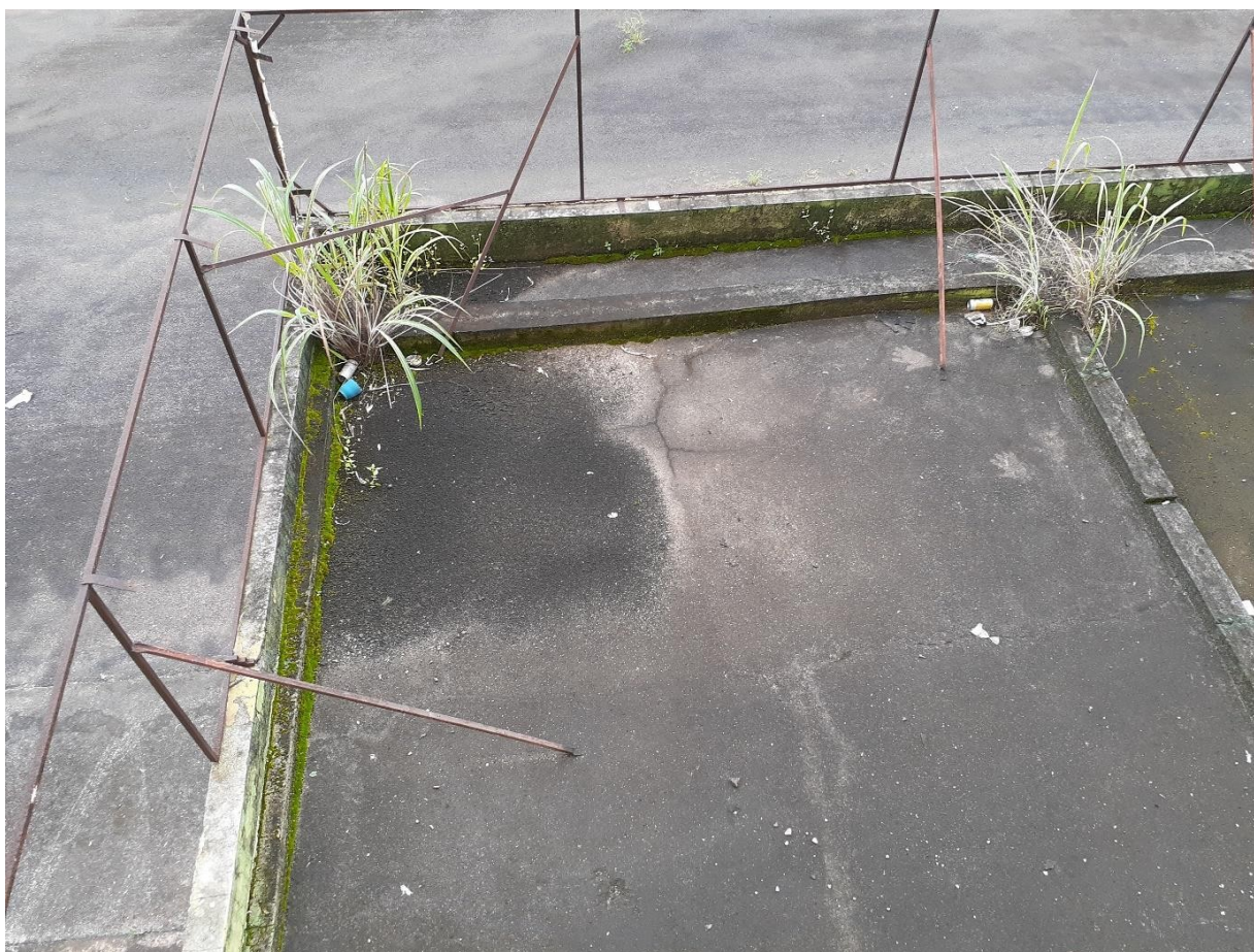
Foto 190: Face superior da laje
