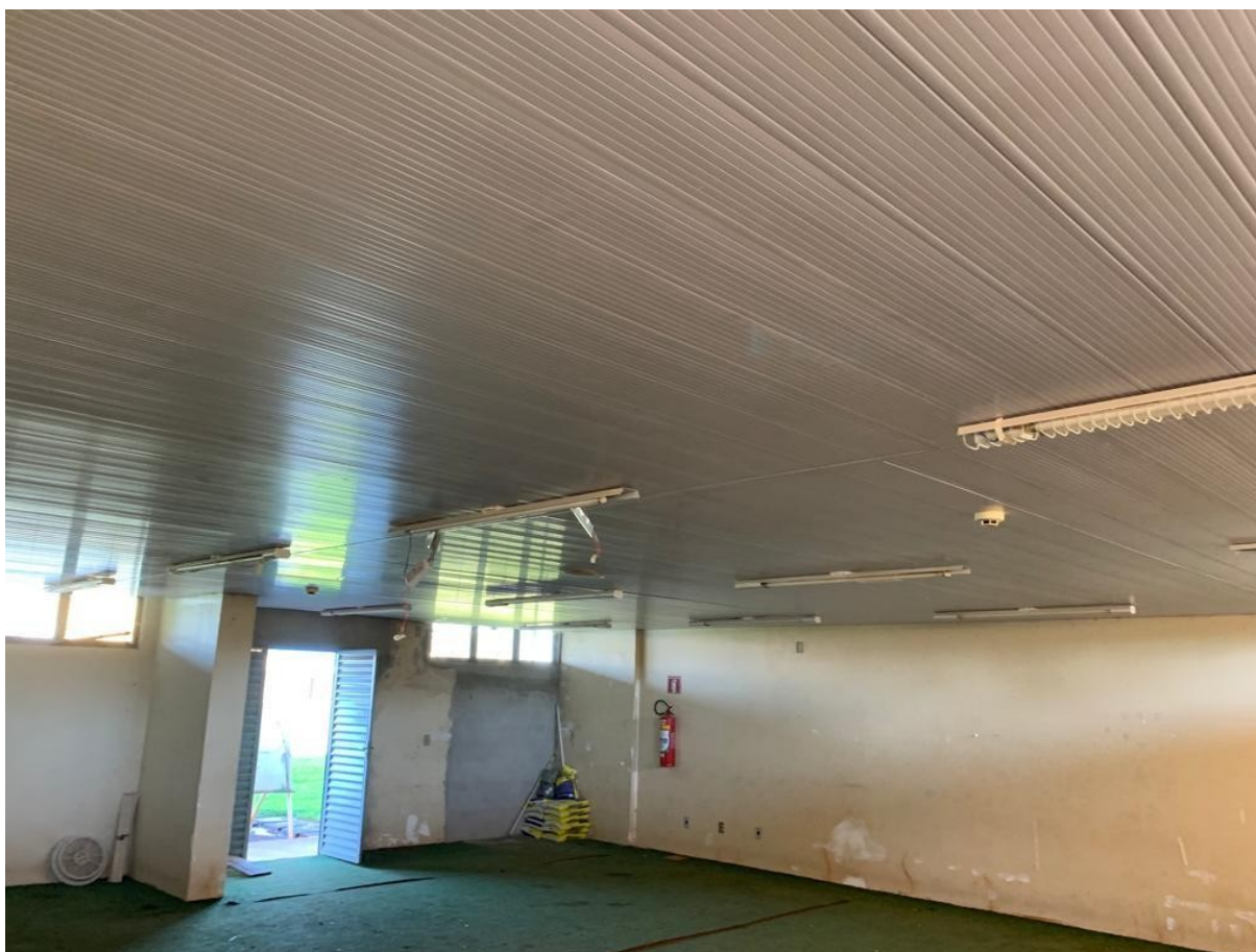
Foto 194: Vista área de aquecimento
