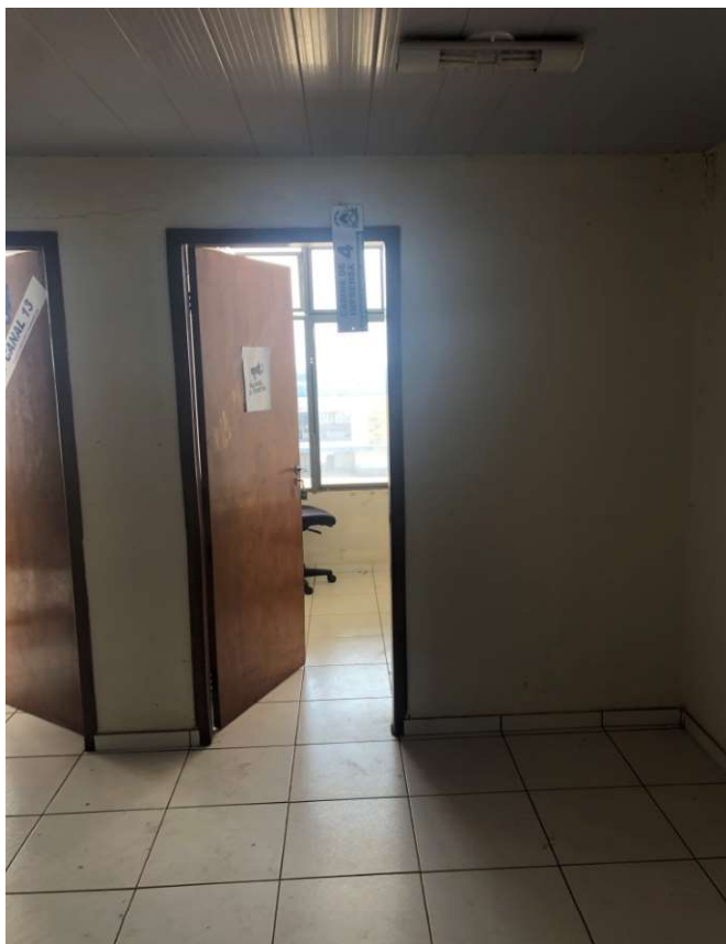
Foto 026: Vista entrada da cabine 4
