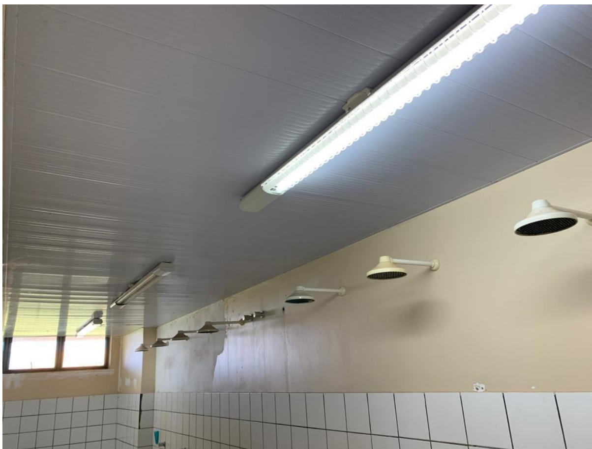
Foto 196: Vista dos Sanitários
