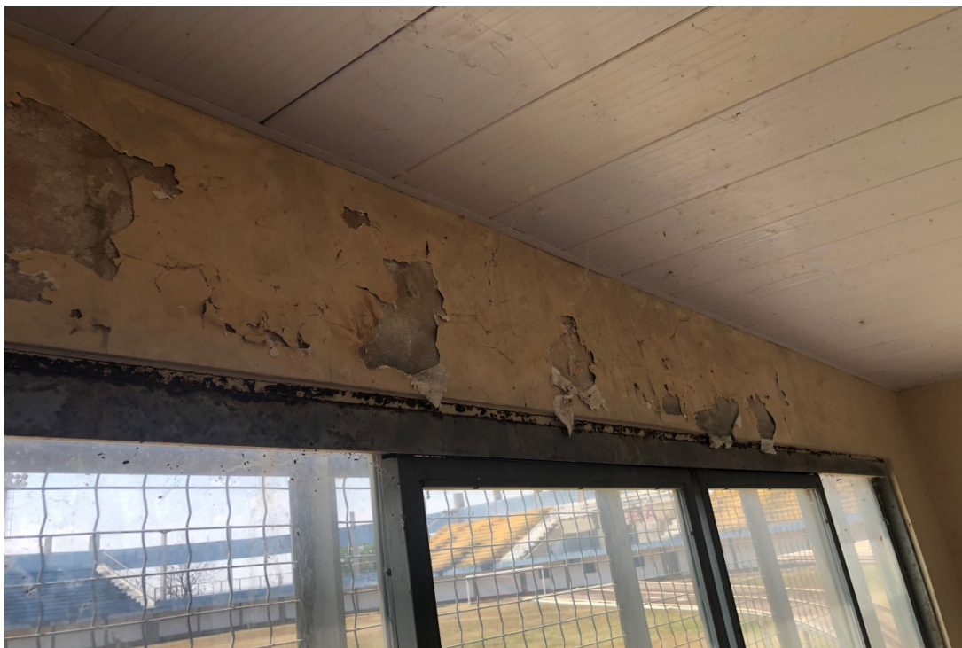
Foto 204: Vista revestimento das paredes
