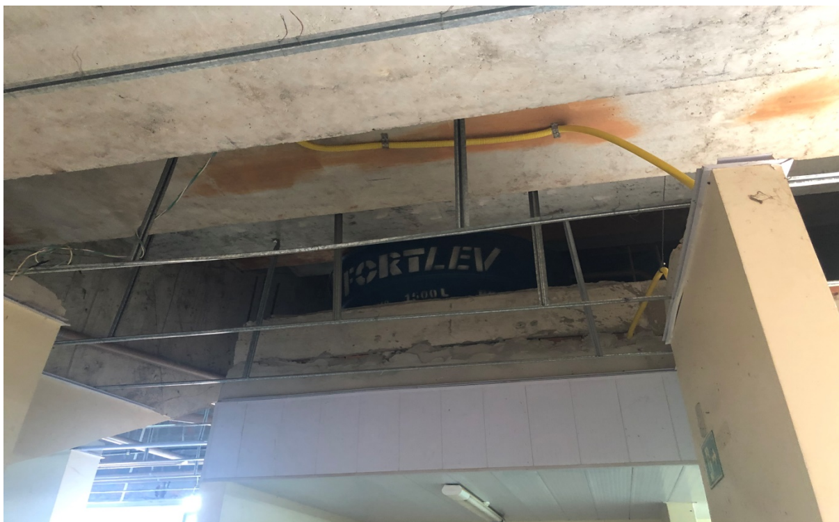
Foto 083: Vista da cobertura
