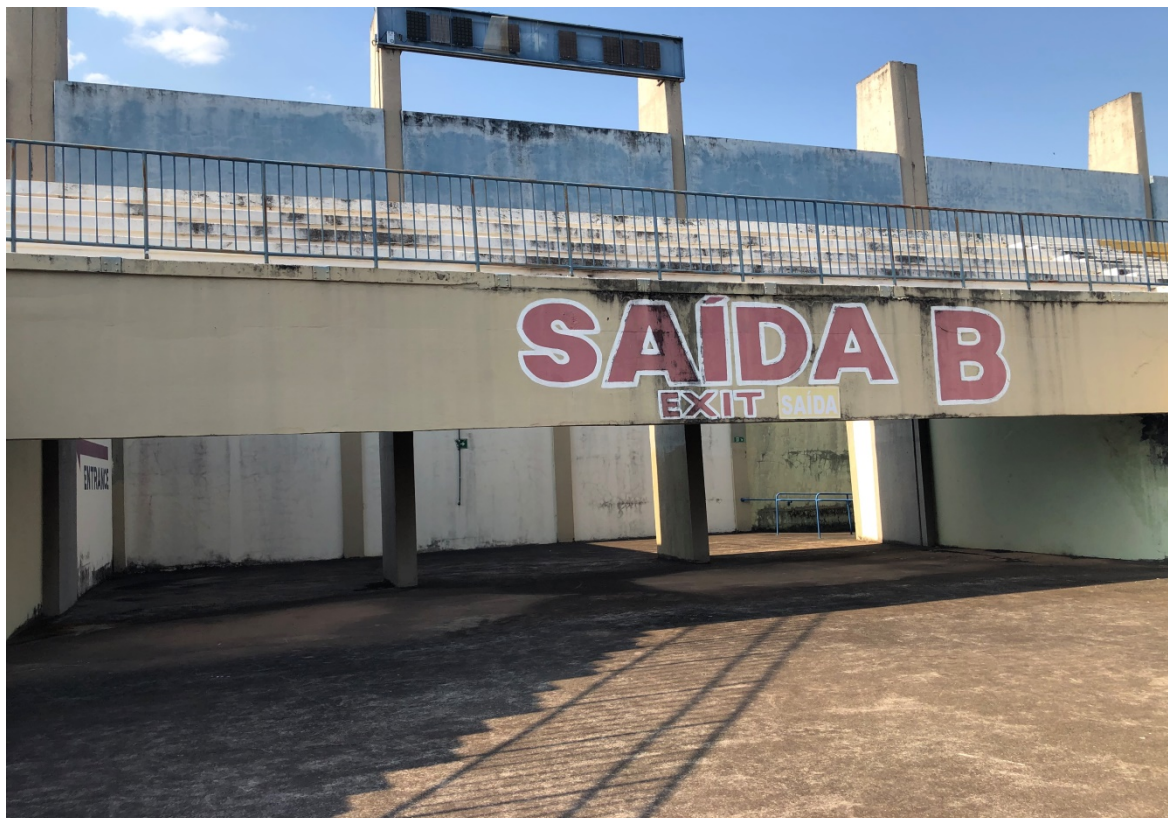
Foto 232: Vista geral saída B
