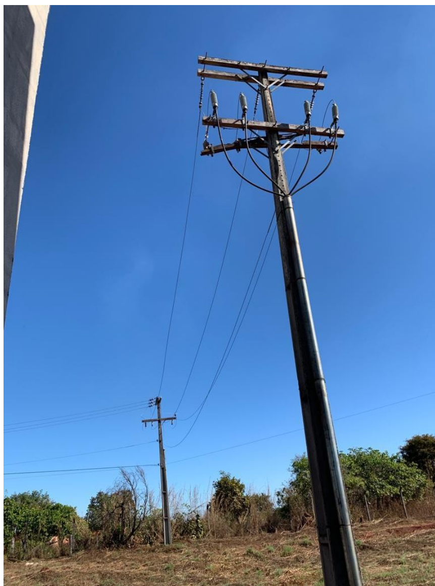
Foto 106: Postejamento aos fundos do estádio
