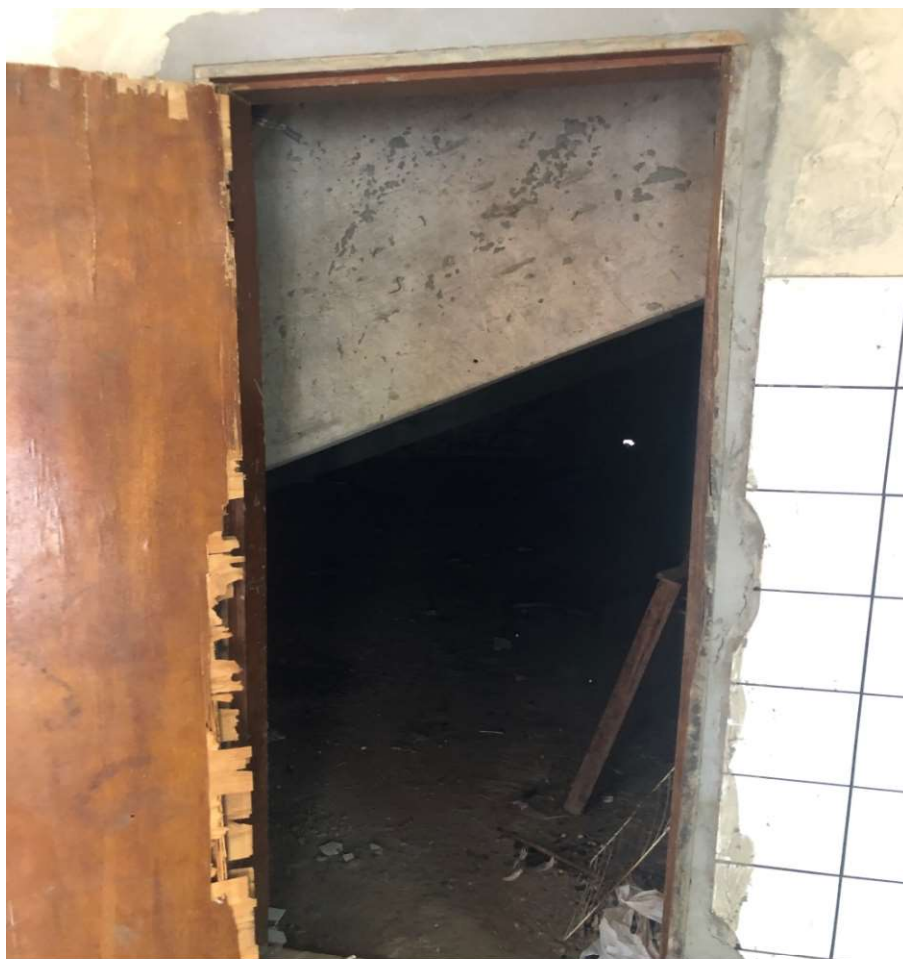
Foto 084: Vista da entrada do depósito
