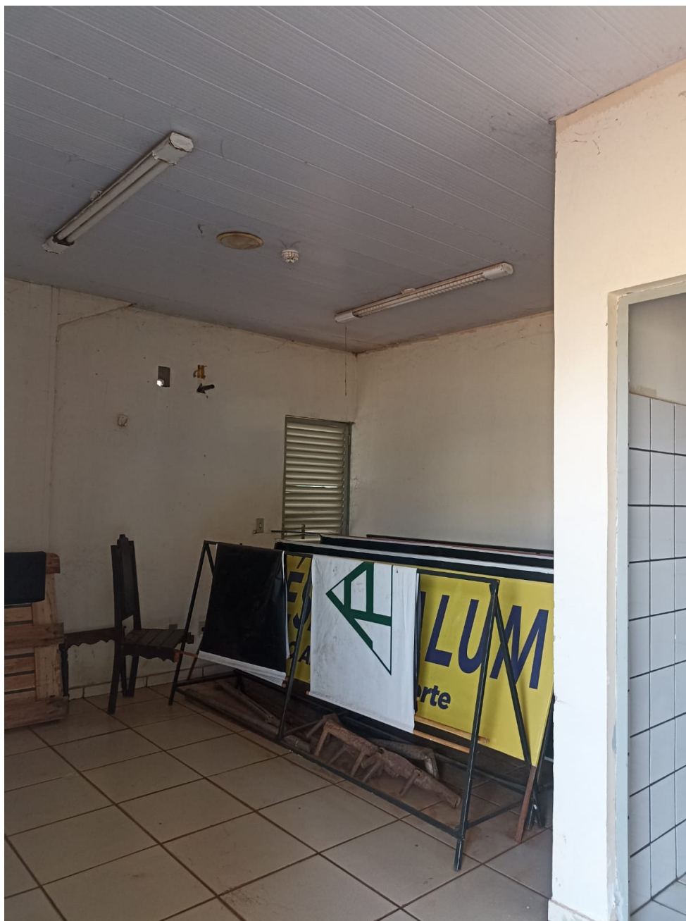
Foto 224: Vista da sala do apoio policial
