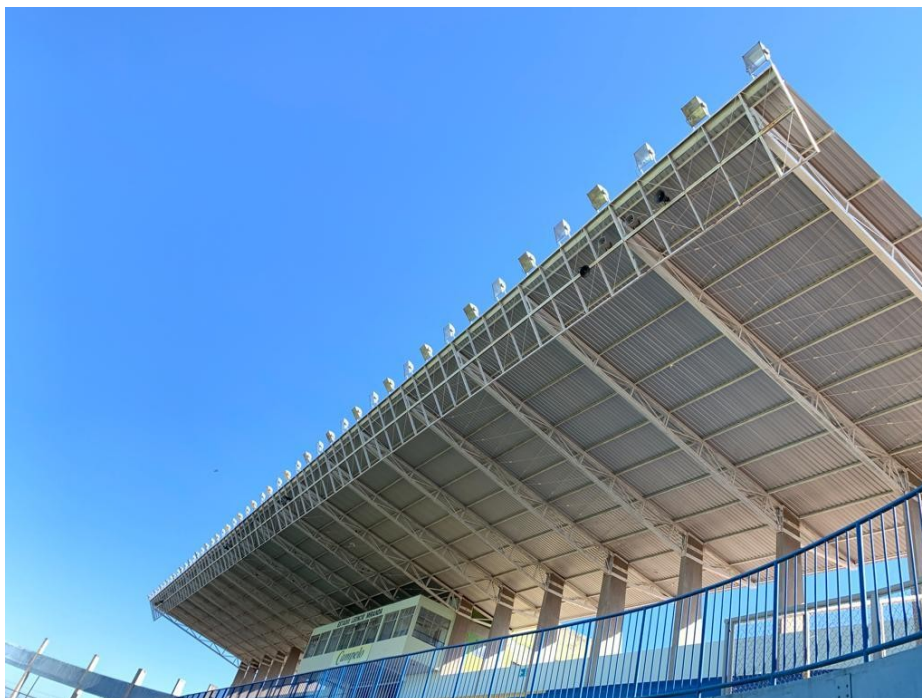
Foto 010: Vista da cobertura sobre arquibancadas
