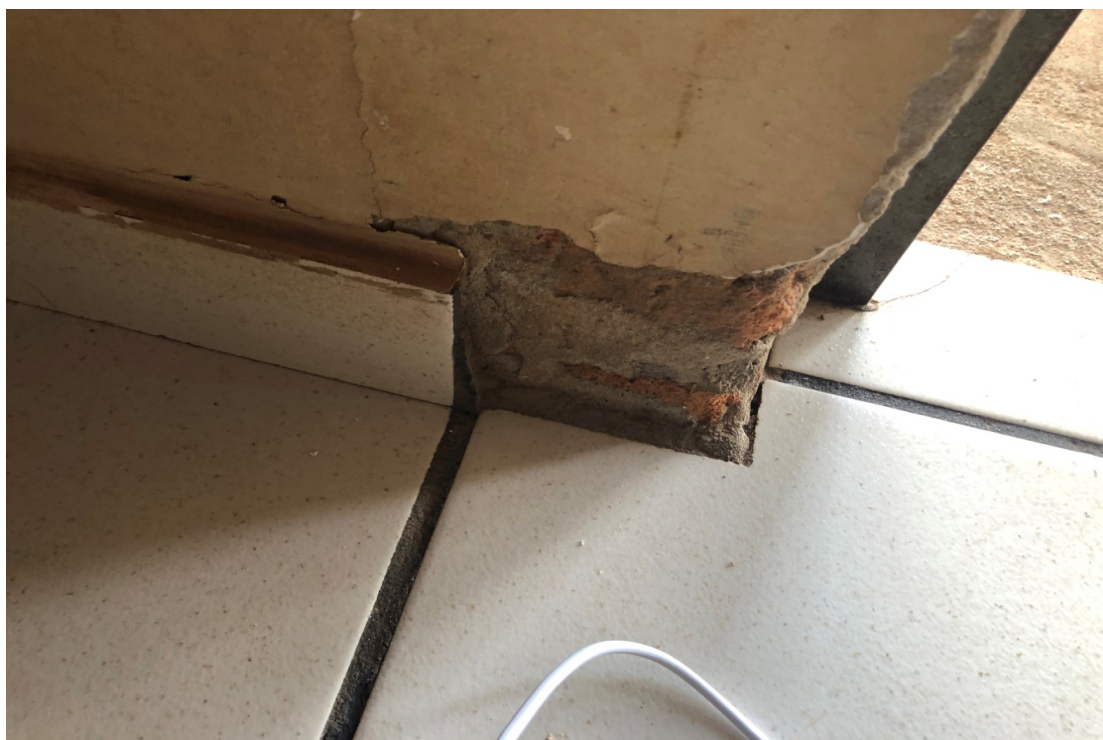
Foto 213: Vista revestimento das paredes
