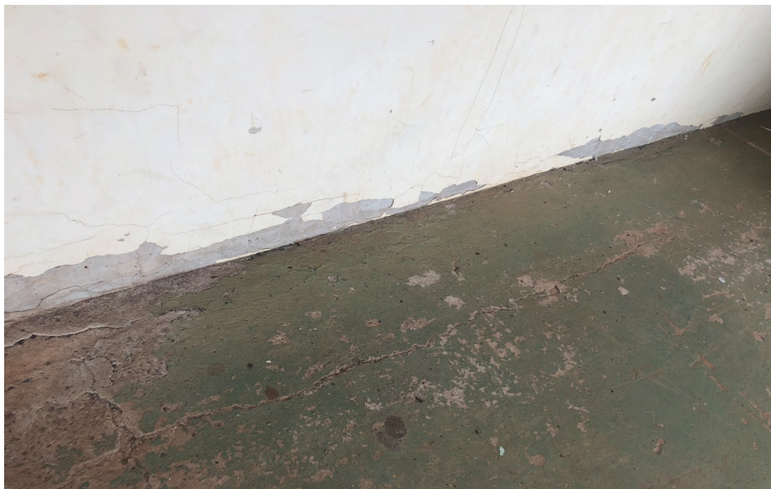
Foto 072: Vista bancada e piso área circulação
