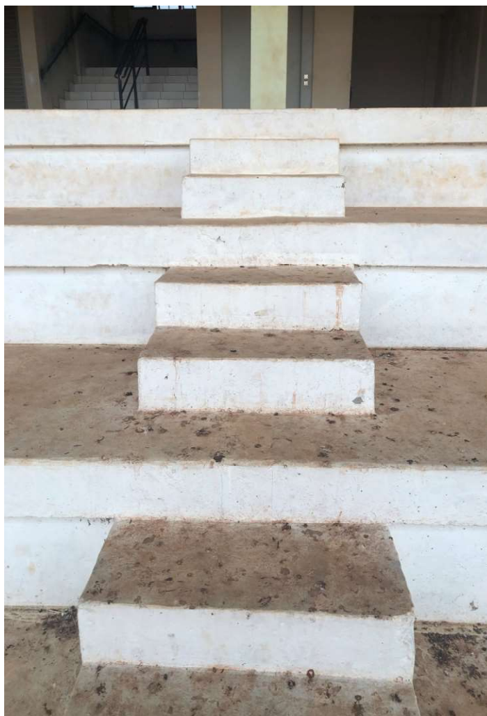
Foto 057: Vista arquibancada camarote
