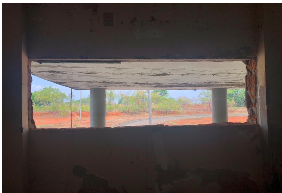
Foto 102: Janela da escada de acesso a cabine através da galeria
