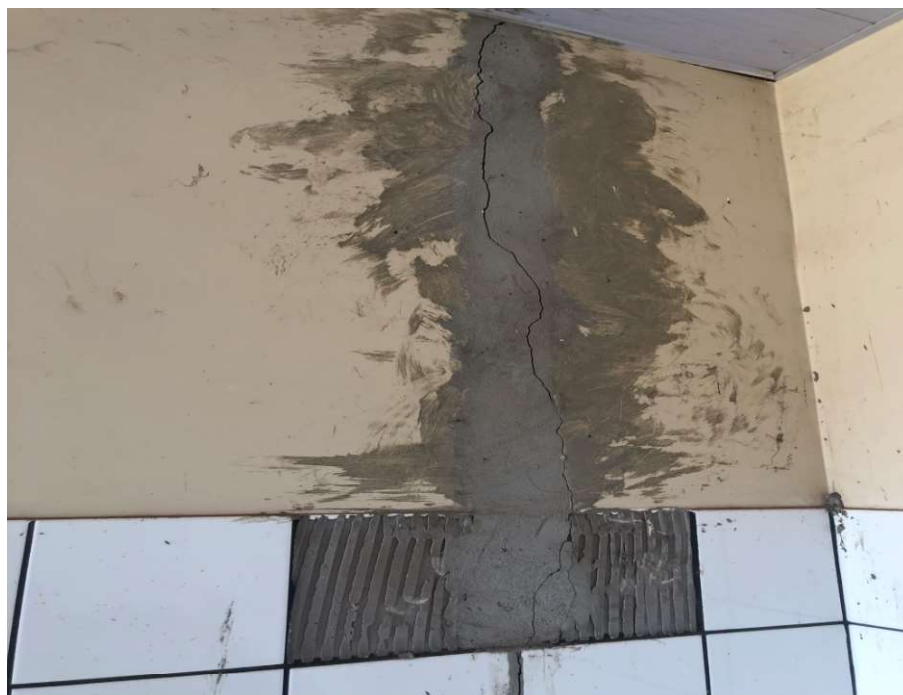
Foto 073: Vista parede interna
