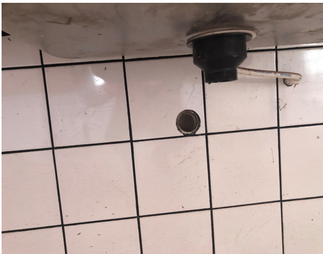
Foto 063: Vista parte inferior da pia
