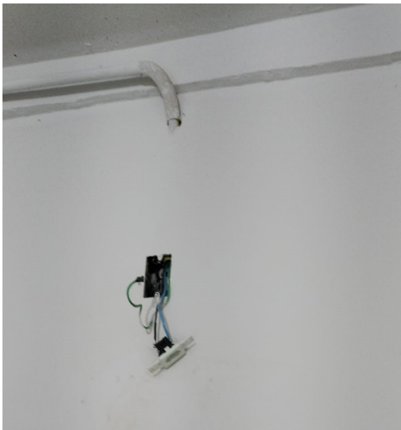
Foto 225: Vista componente elétrico exposto
