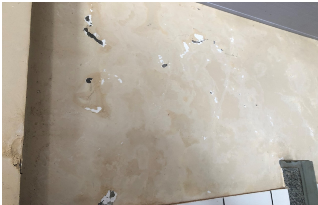
Foto 212: Vista revestimento das paredes
