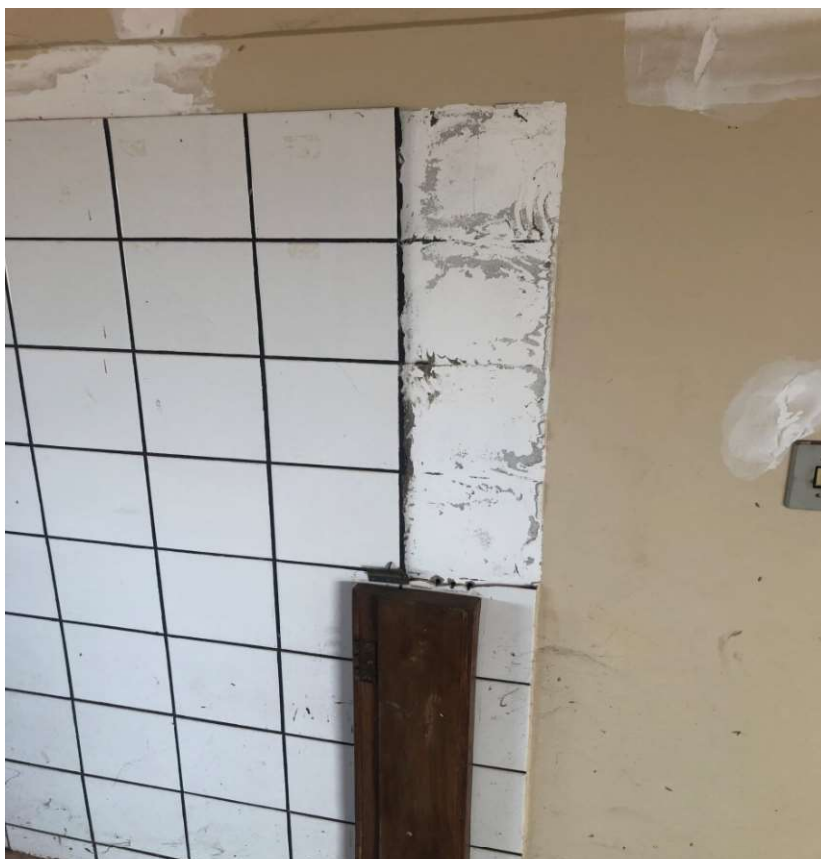
Foto 061: Vista revestimento cerâmico
