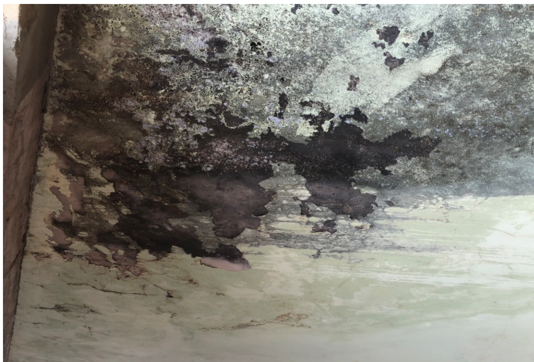
Foto 235: Vista geral paredes saída B
