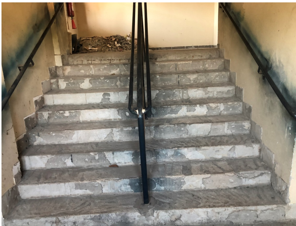
Foto 104: Escada 3 de acesso a cabine através da galeria
