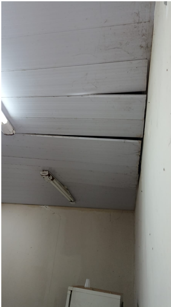
Foto 220: Vista forro secretaria B
