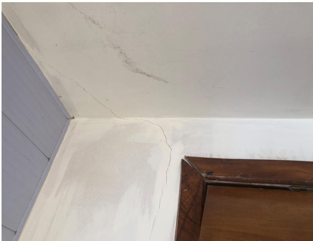
Foto 029: Vista parede da cabine 4
