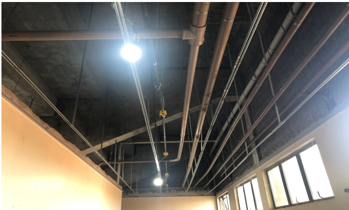
Foto 082: Vista da cobertura
