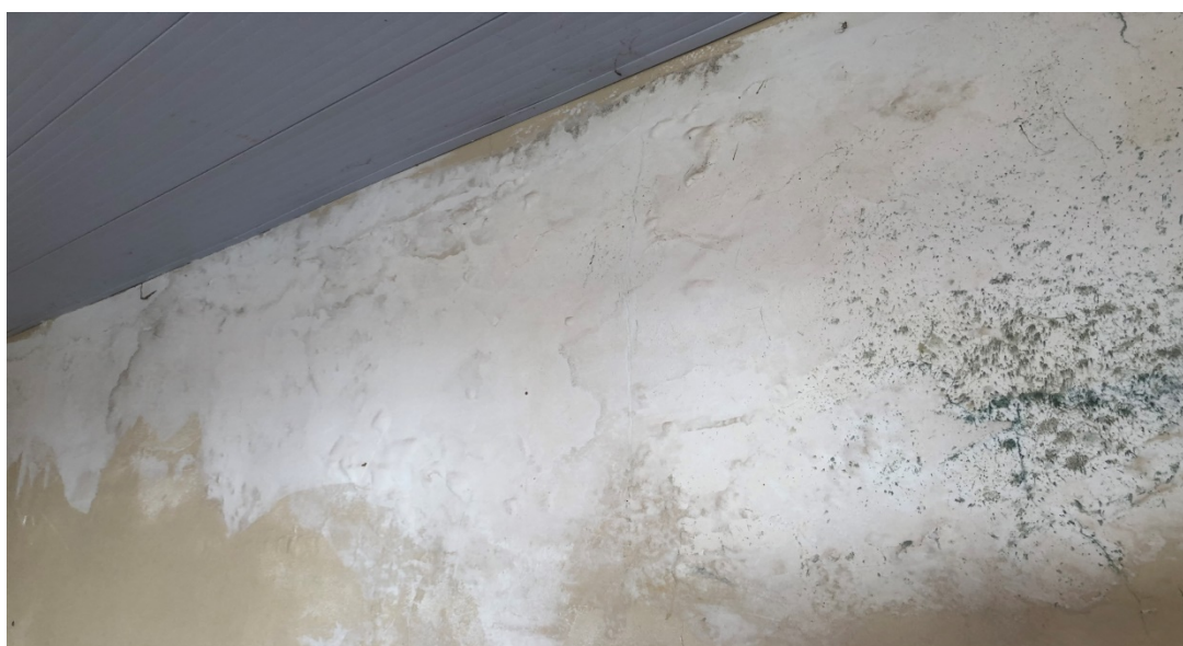
Foto 042: Vista da parede
