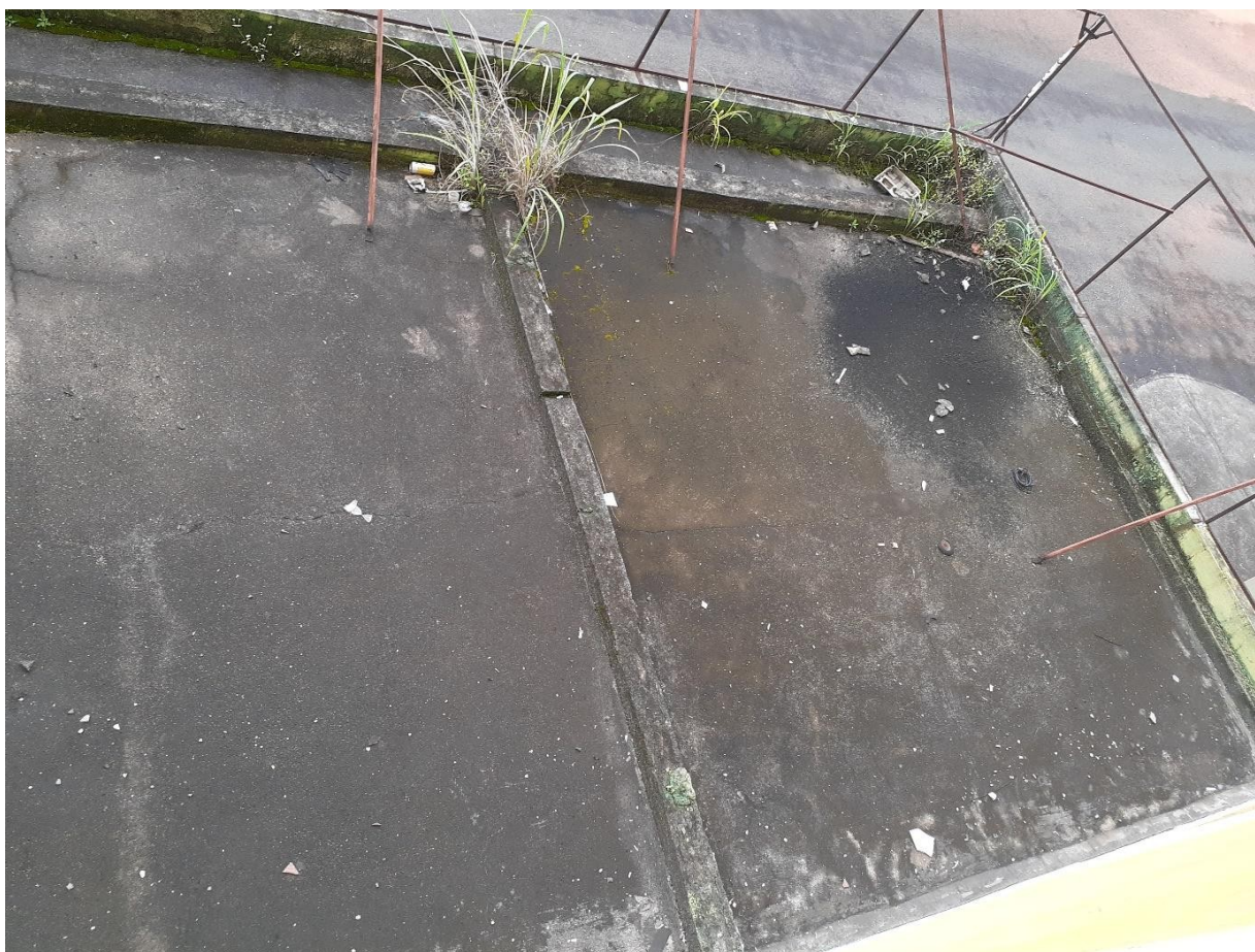
Foto 189: Face superior da laje
