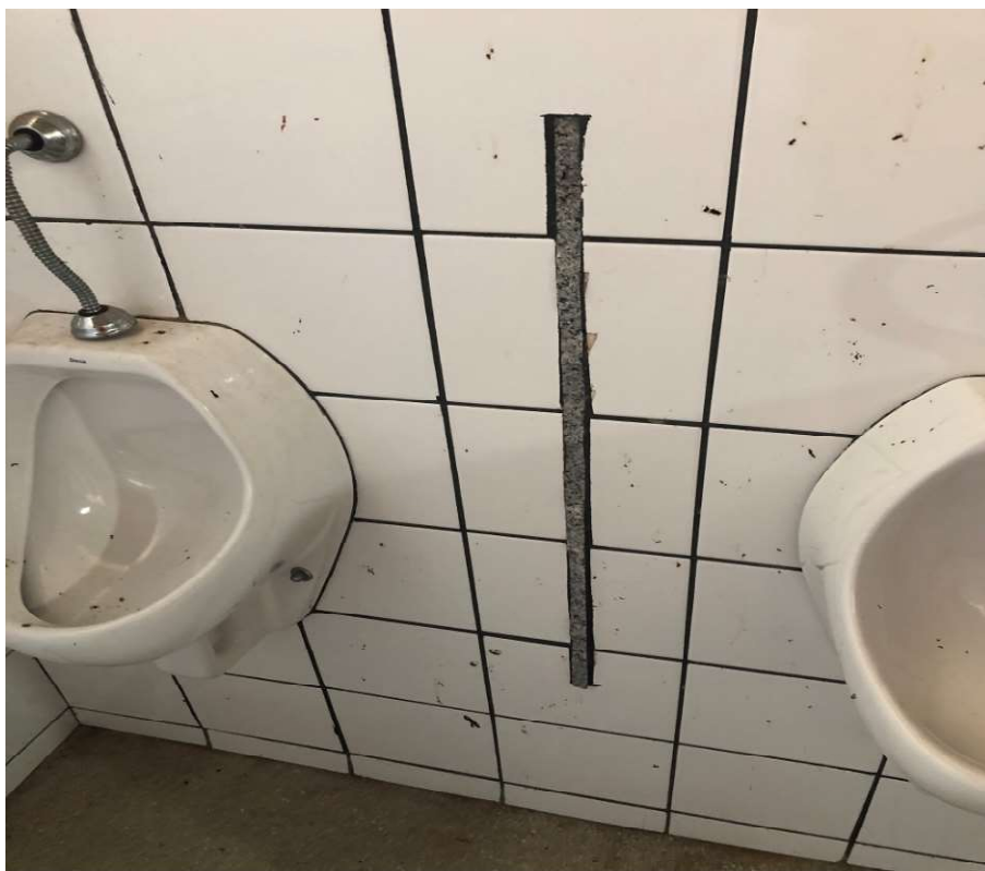
Foto 087: Vista divisória do mictório
