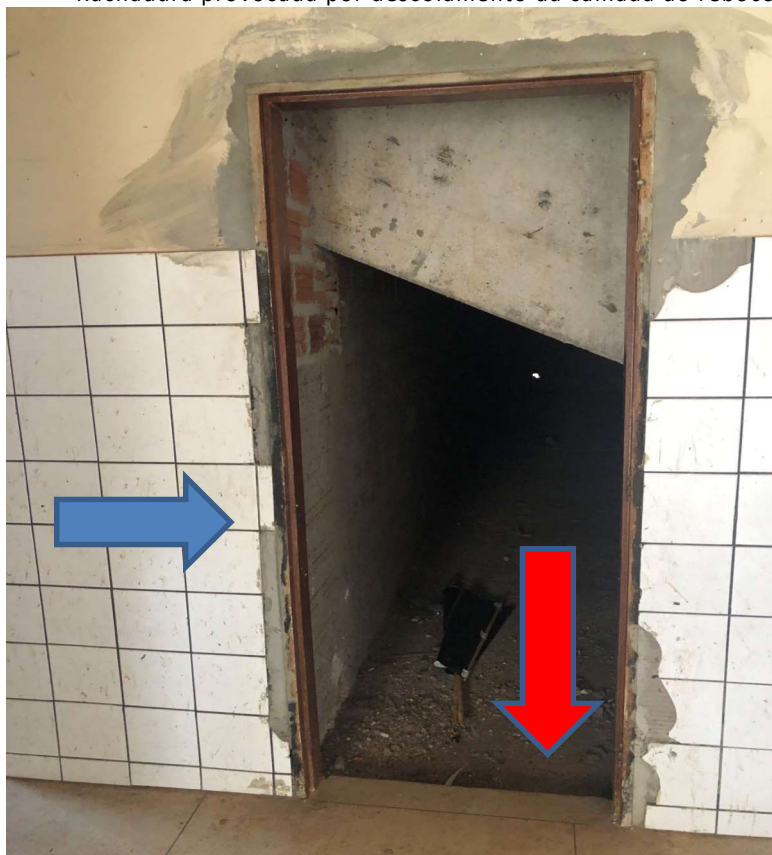
Foto 092: Vista entrada do depósito
