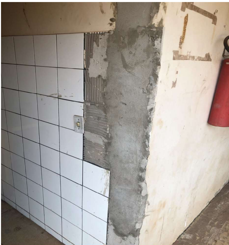
Foto 081: Vista da parede de entrada
