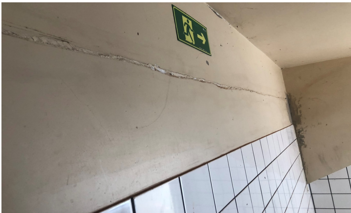
Foto 091: Vista revestimento interno
