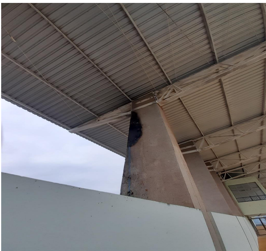
Foto 011: Vista parcial da cobertura sobre arquibancadas
