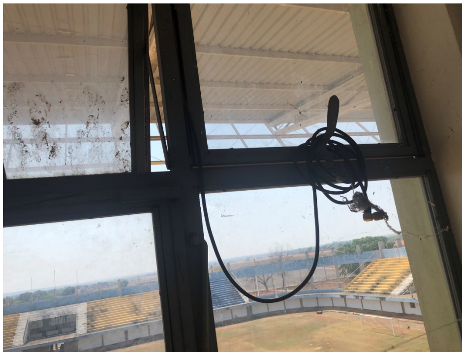
Foto 036: Vista janela da cabine 6
