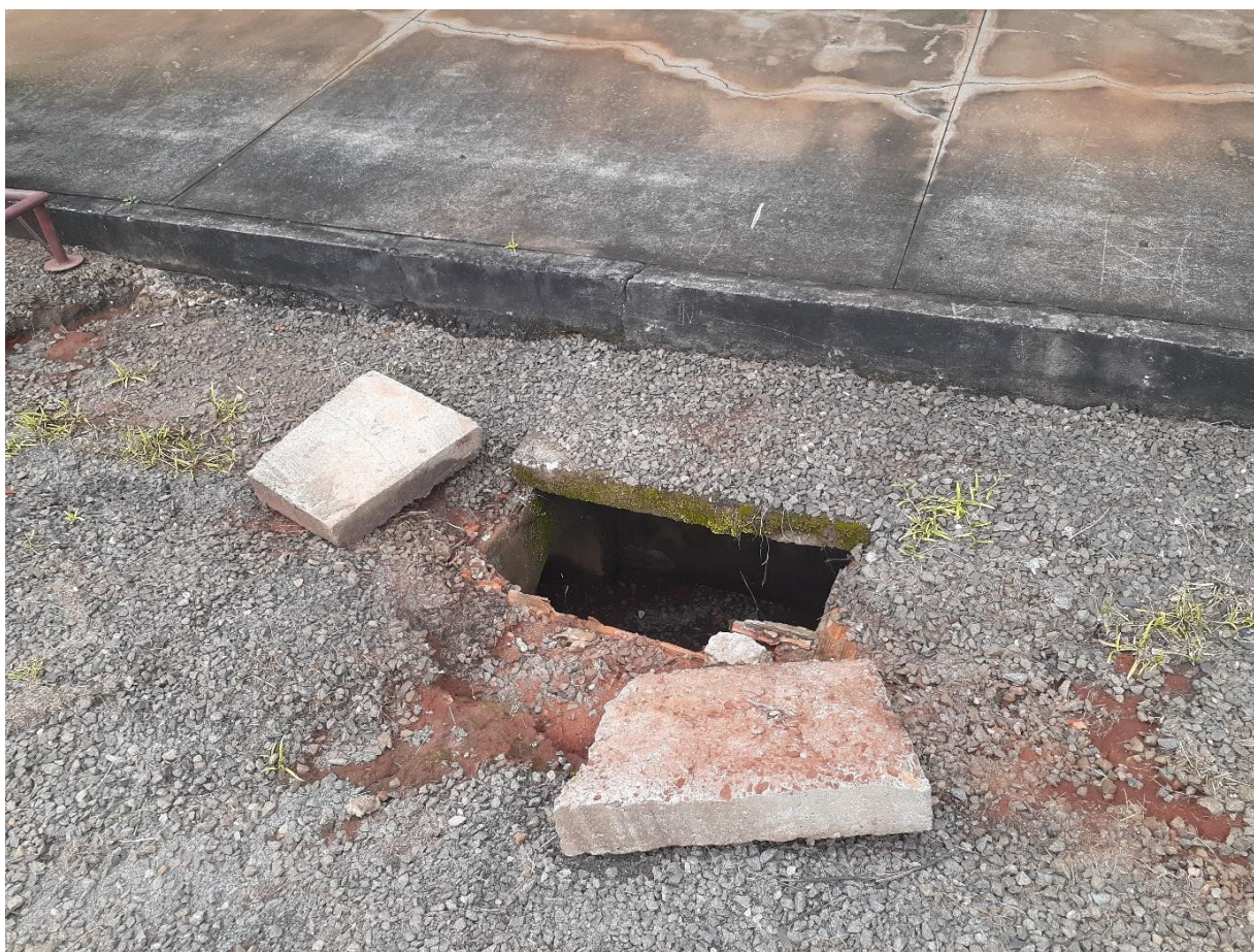
Foto 174: Rede de drenagem pluvial – área de escape
