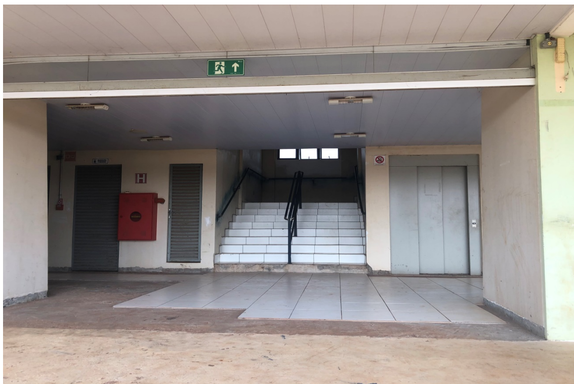
Foto 050: Vista circulação - camarote (lado esquerdo)
