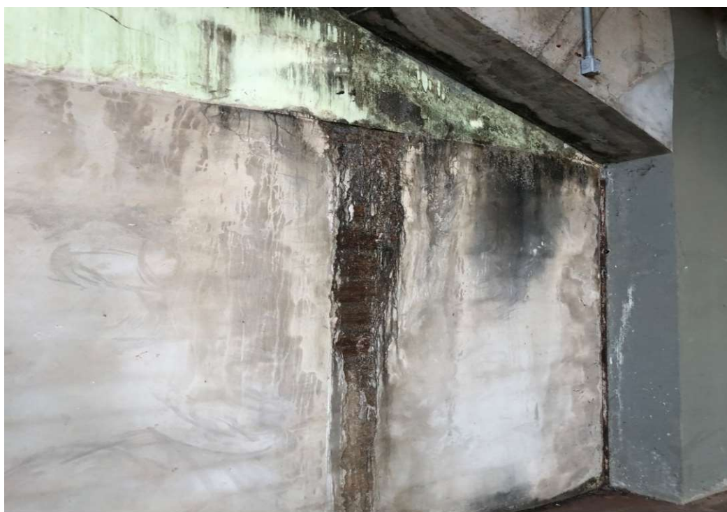
Foto 230: Vista revestimento das paredes
