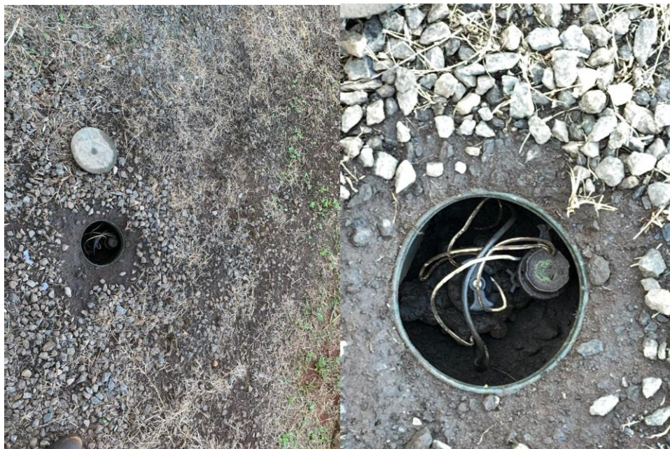
Foto 136: Sensor de acionamento do sistema de irrigação.
