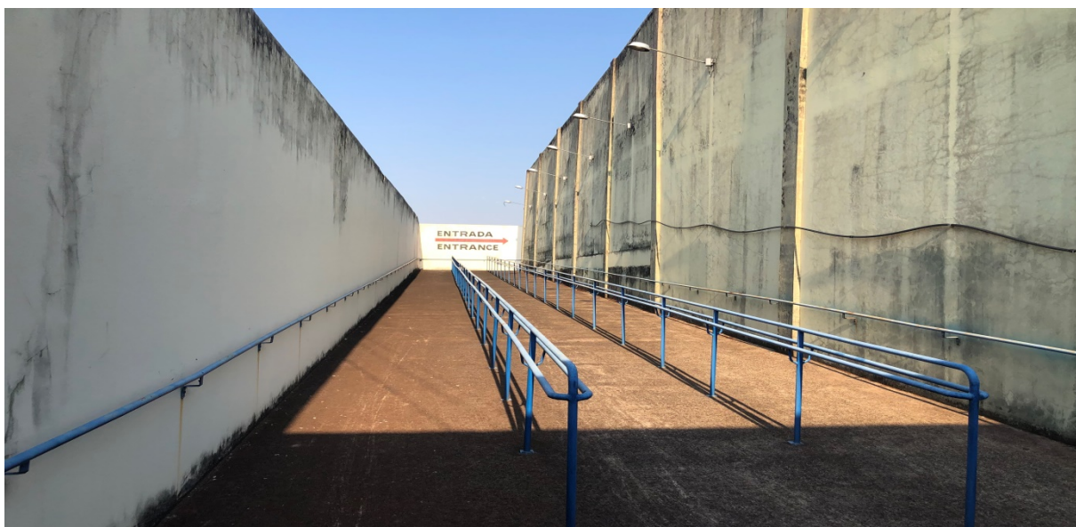
Foto 233: Vista geral saída B
