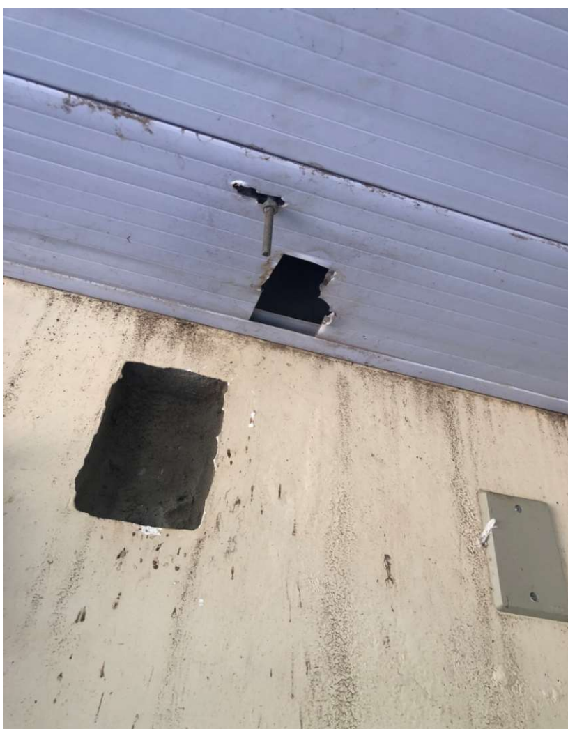
Foto 041: Vista do forro e parede
