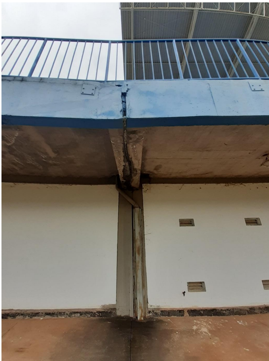
Foto 175: Junta de dilatação
