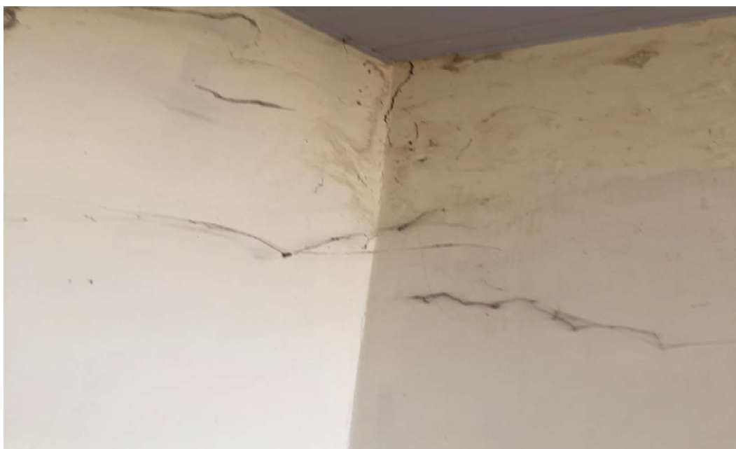
Foto 025: Vista paredes da cabine 3
