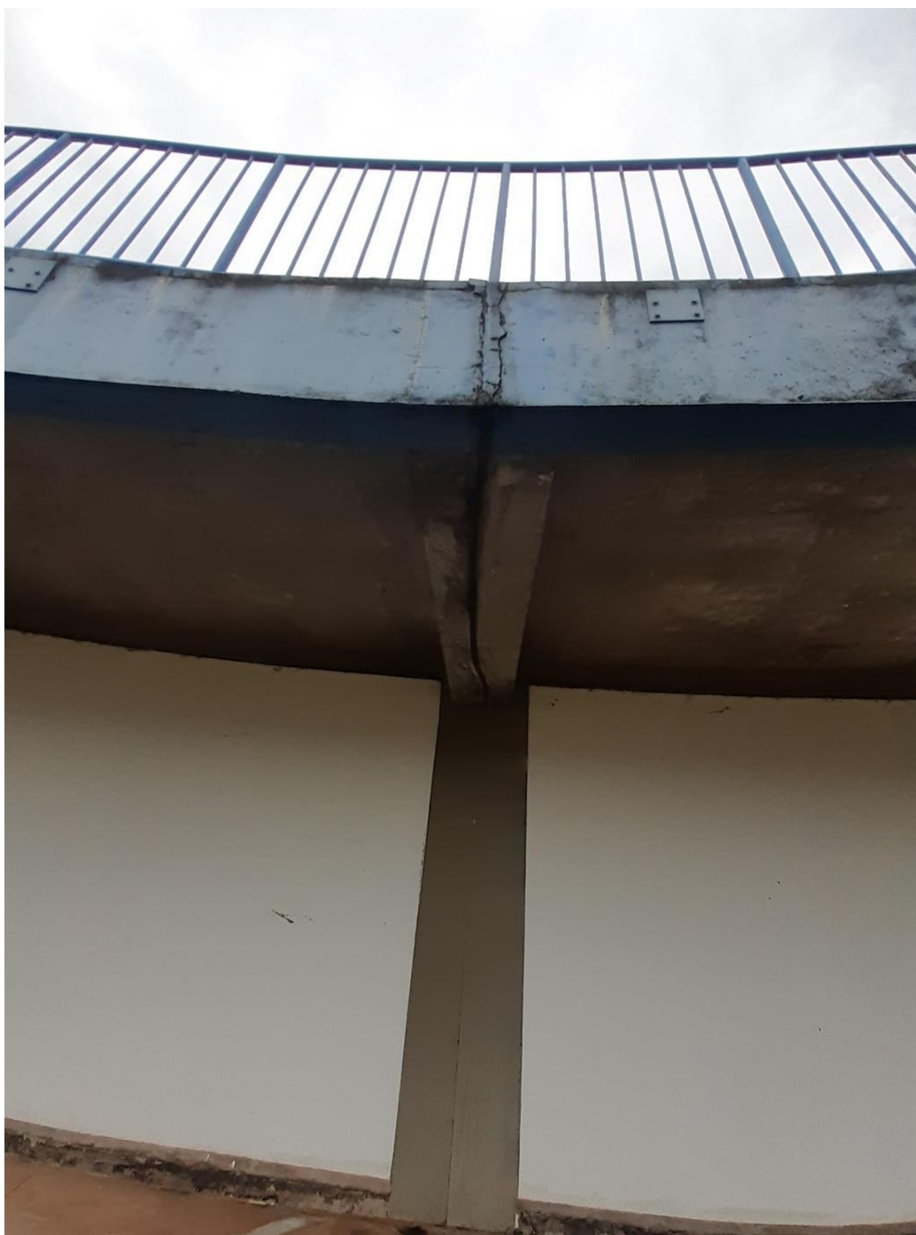
Foto 176: Junta de dilatação
