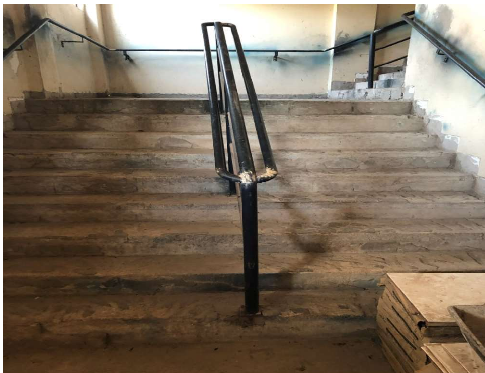
Foto 103: Escada 2 de acesso a cabine através da galeria
