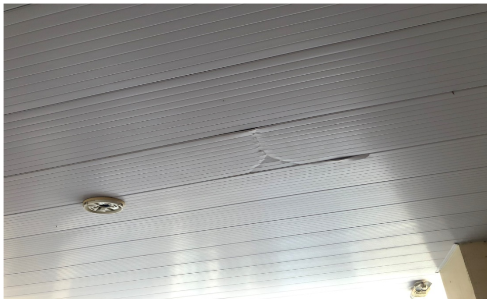
Foto 054: Vista do forro de PVC
