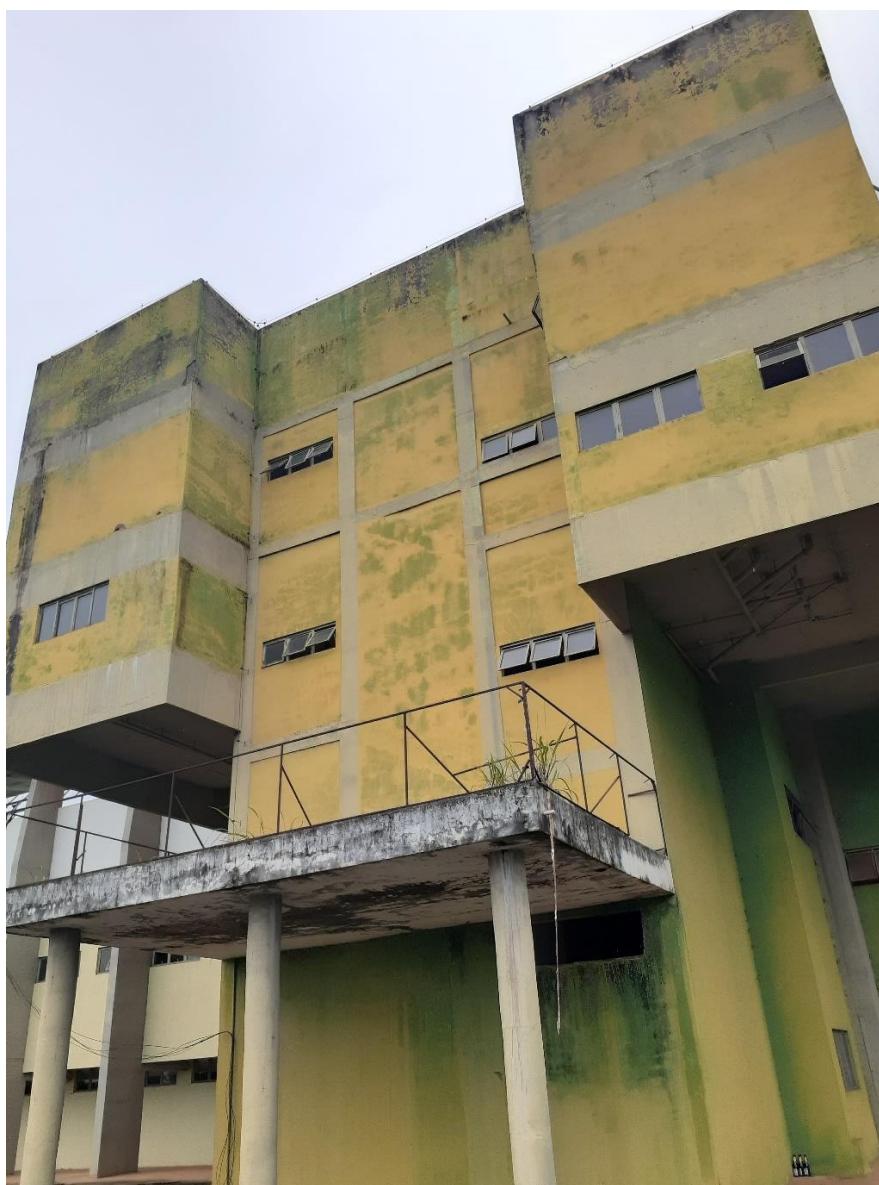
Foto 179: Vista saguão fundos
