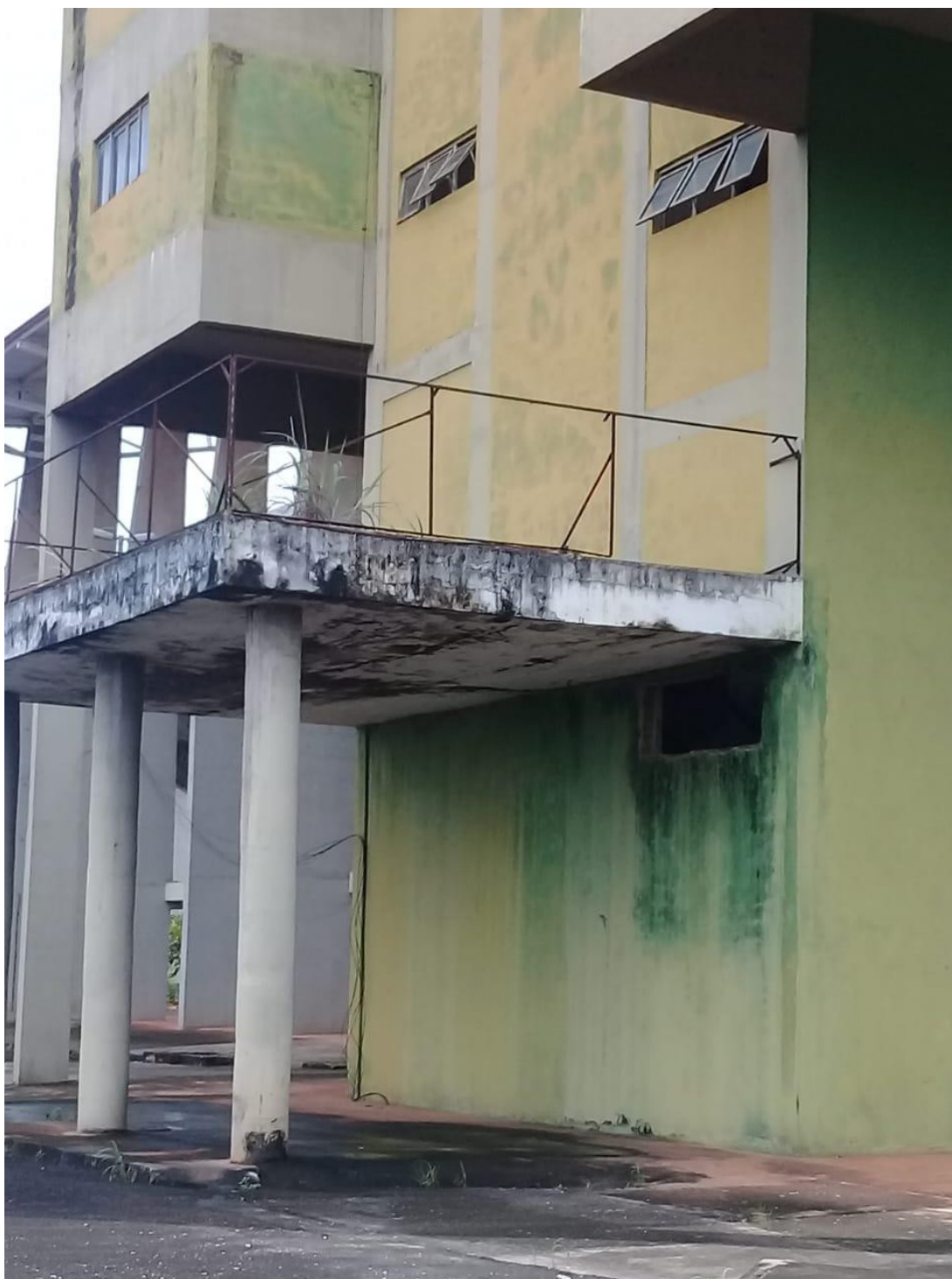
Foto 181: Vista saguão fundos
