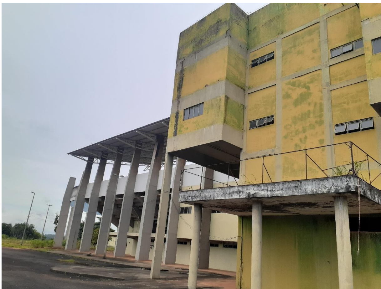
Foto 180: Vista saguão fundos
