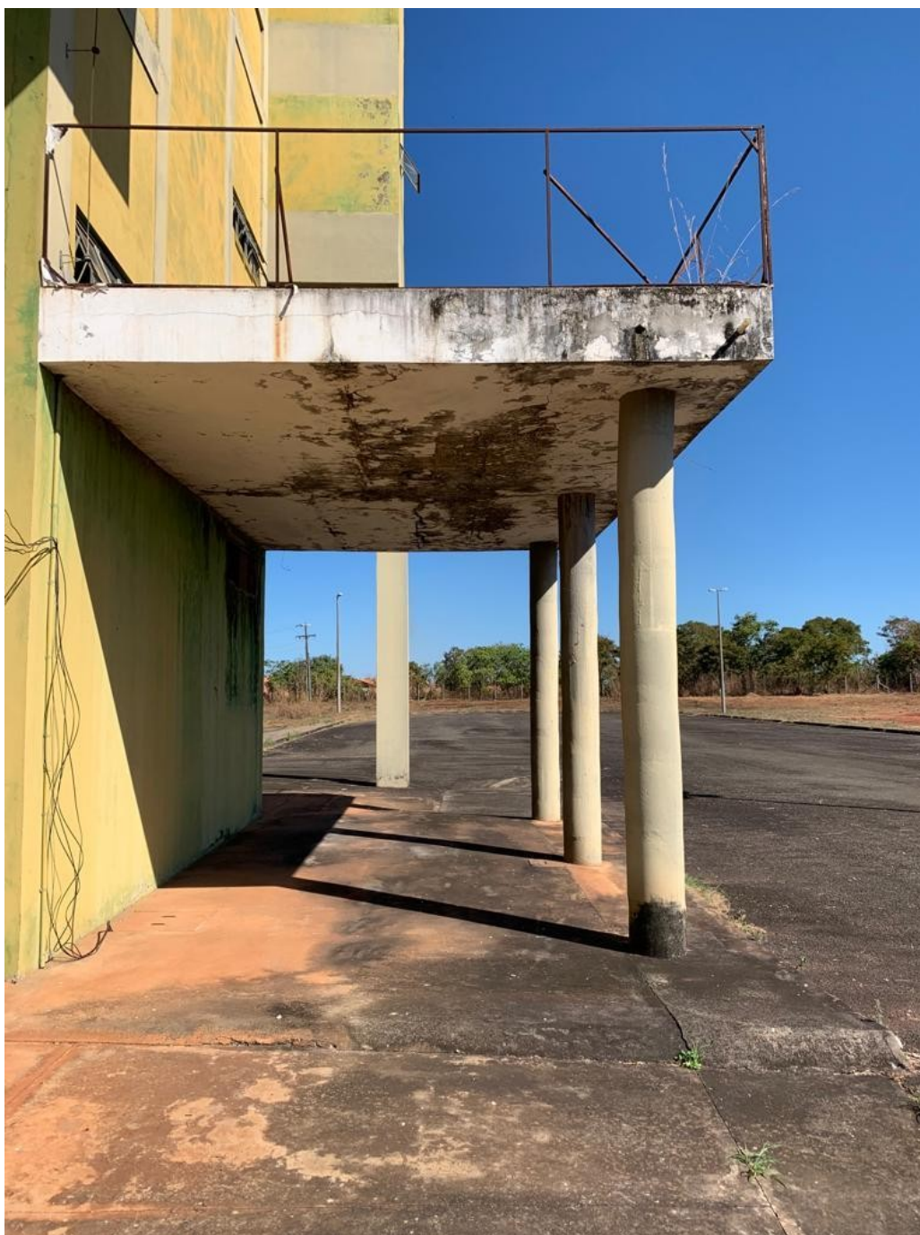
Foto 182: Vista saguão fundos
