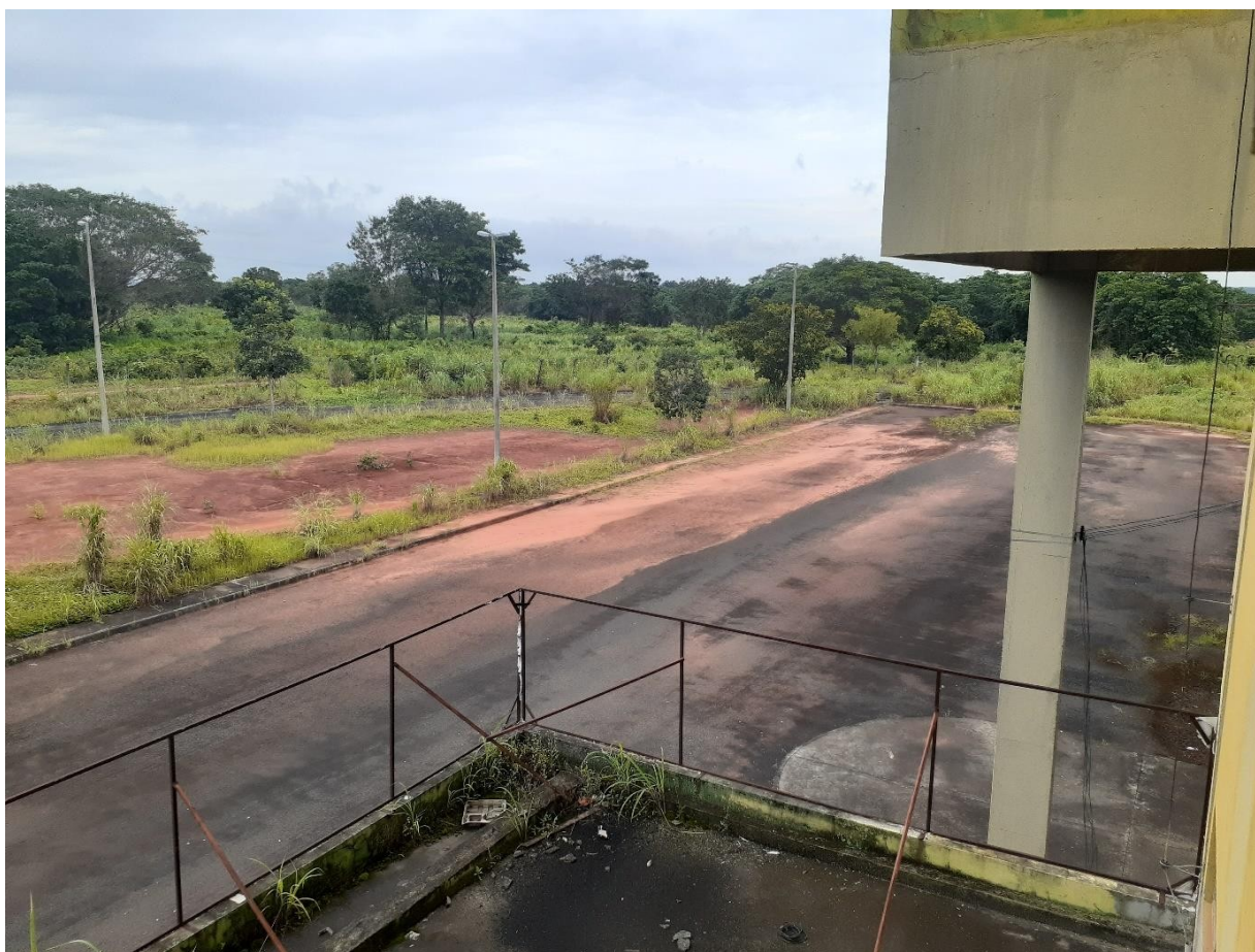
Foto 188: Face superior da laje
