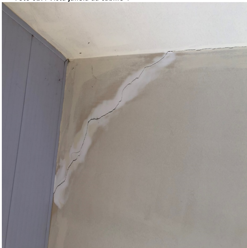
Foto 028: Vista parede da cabine 4
