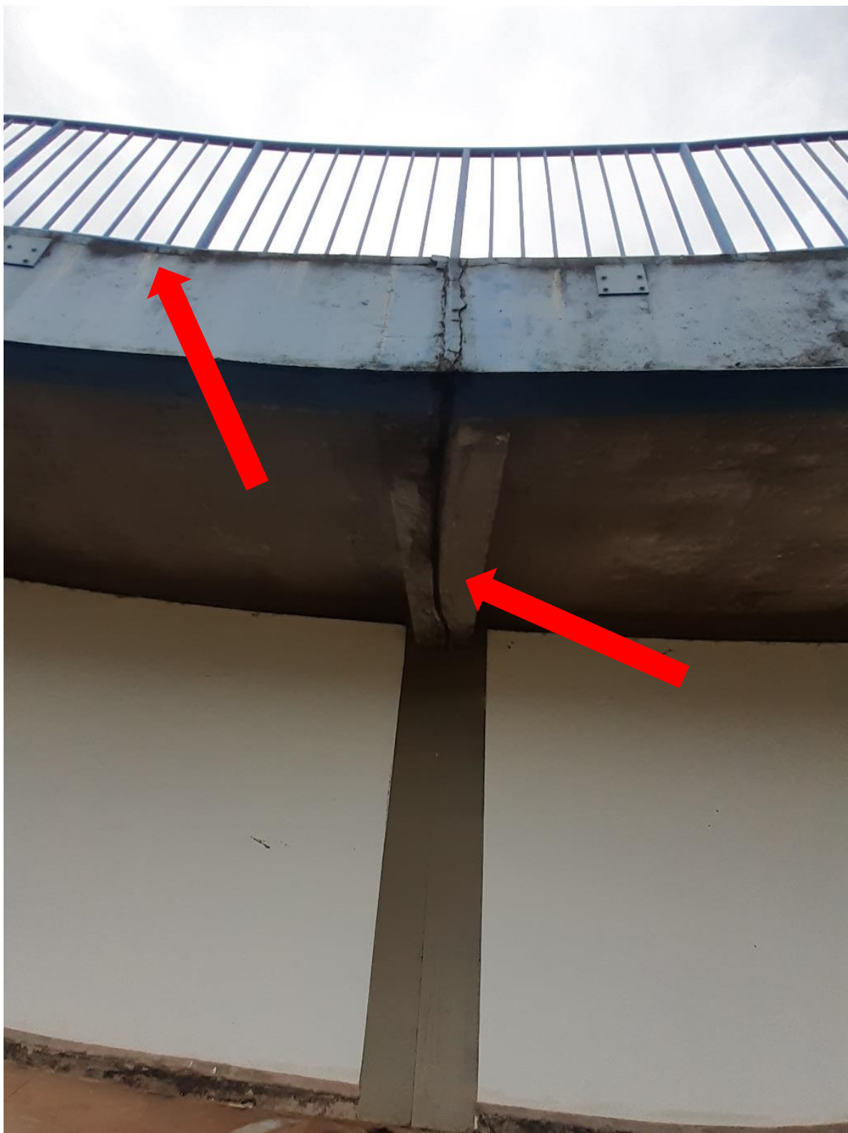
Foto 146: junta de dilatação de caráter estrutural
