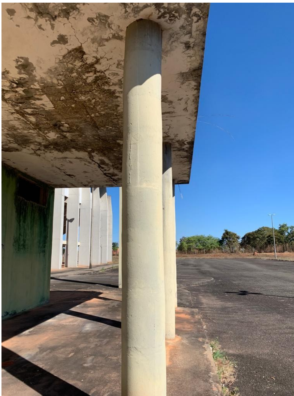
Foto 184: Vista saguão fundos – face inferior da laje
