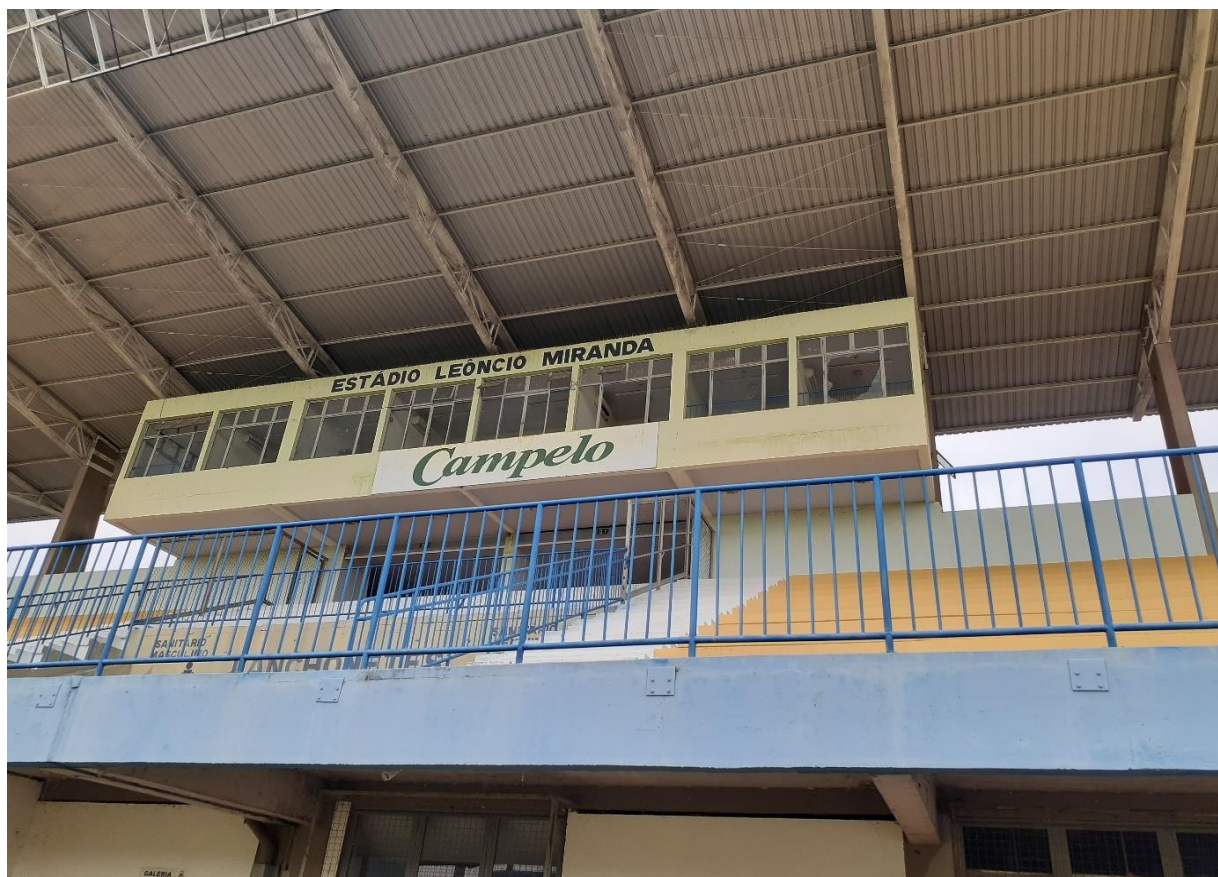
Foto 014: Vista geral da cabine
