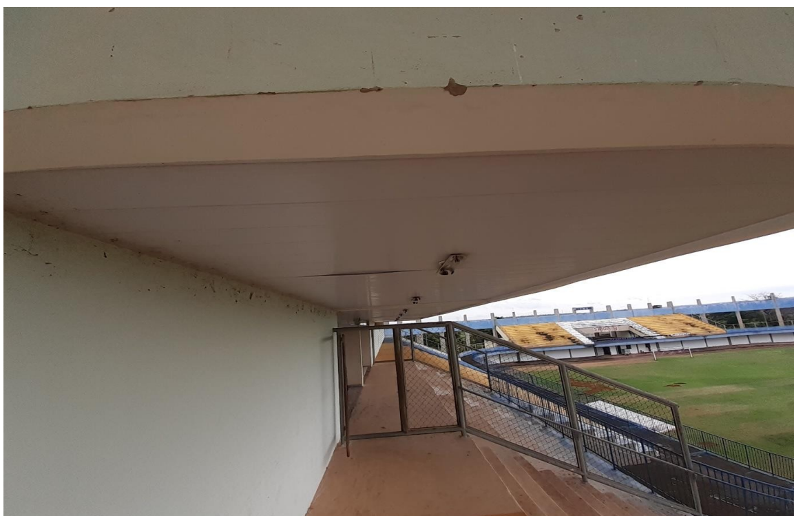
Foto 018: Vista inferior da cabine
