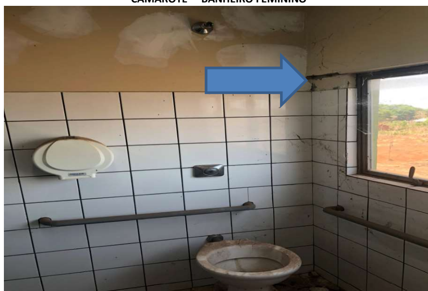
Foto 067: Vista banheiro feminino
