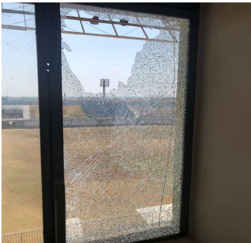
Foto 027: Vista janela da cabine 4
