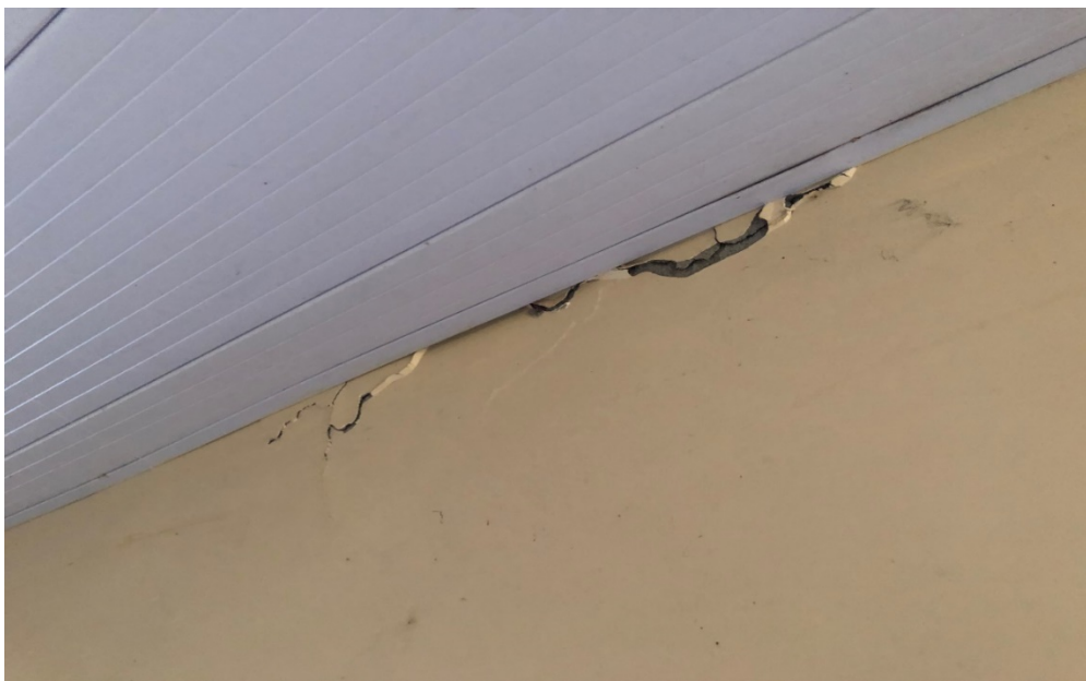
Foto 214: Vista revestimento das paredes
