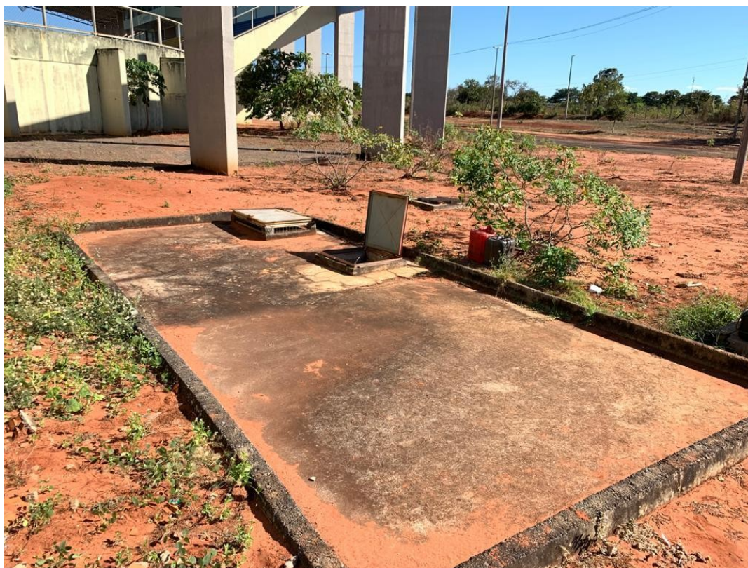
Foto 117: Vista a partir do reservatório enterrado de água consumo
