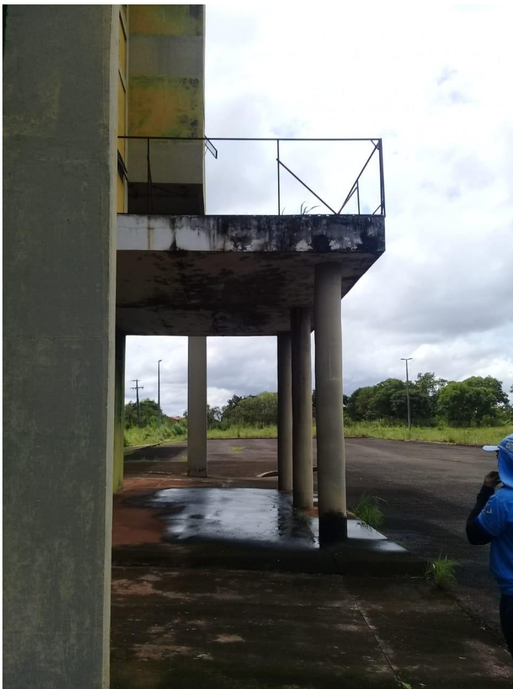
Foto 183: Vista saguão fundos
