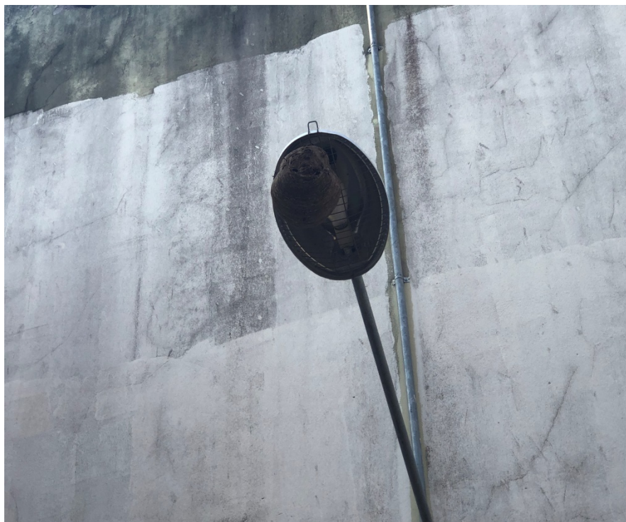
Foto 234: Vista geral iluminação saída B
