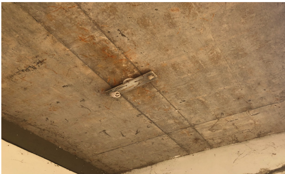
Foto 205: Vista da cobertura
