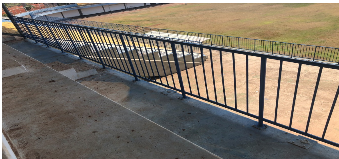
Foto 058: Vista arquibancada e guarda corpo
