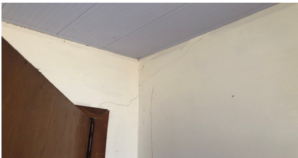
Foto 037: Vista parede da cabine TV e Rede Sat
