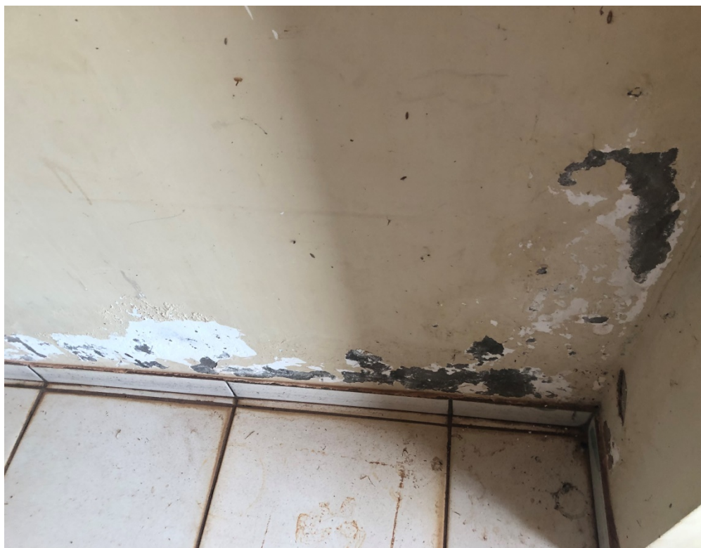
Foto 098: Vista parede da galeria
