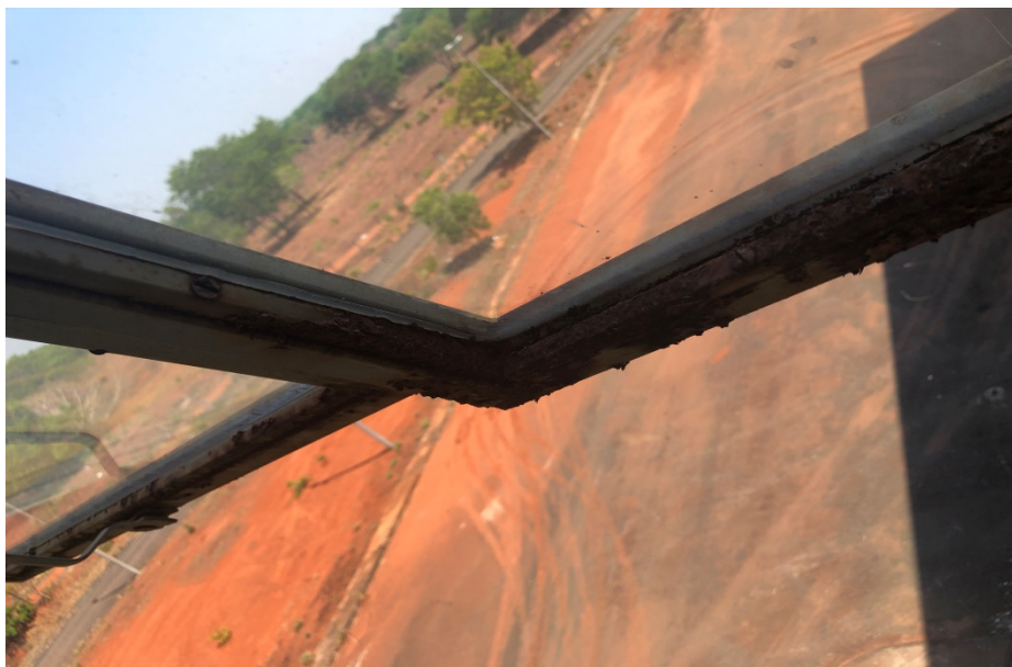
Foto 043: Vista armadura das janelas
