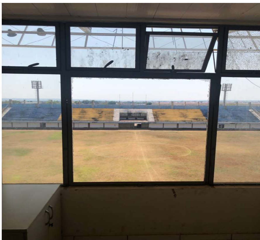
Foto 023: Vista janelas da cabine 3
