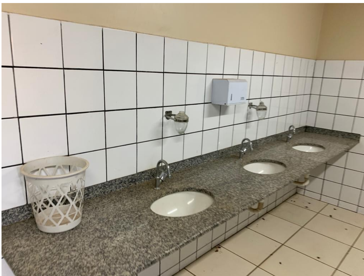
Foto 202: Lavatórios dos Sanitários
