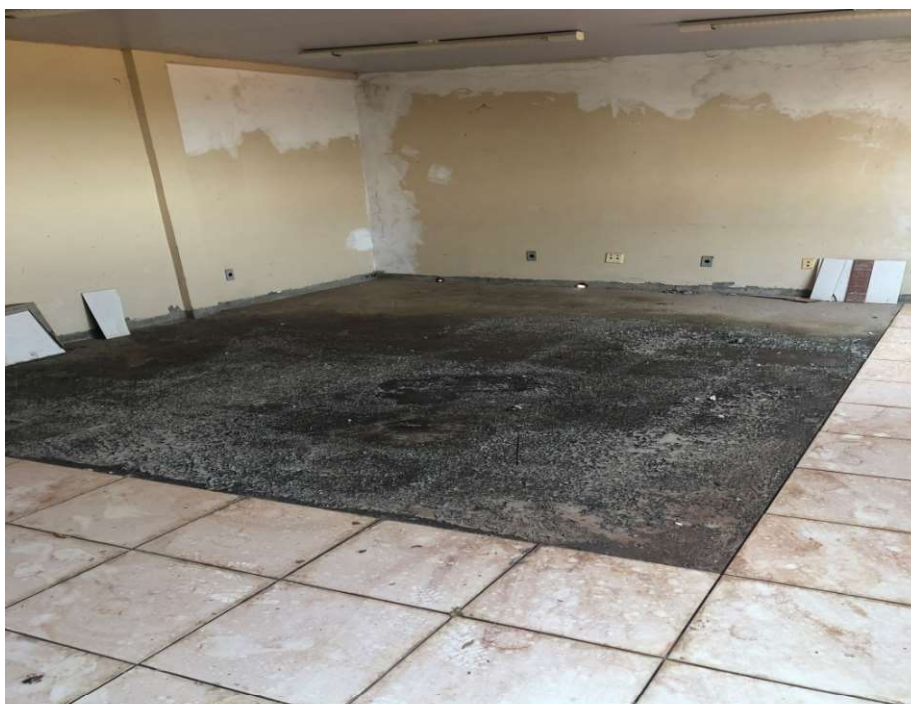
Foto 040: Vista piso da sala de apoio a imprensa
