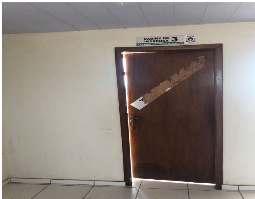
Foto 022: Vista entrada da cabine 3
