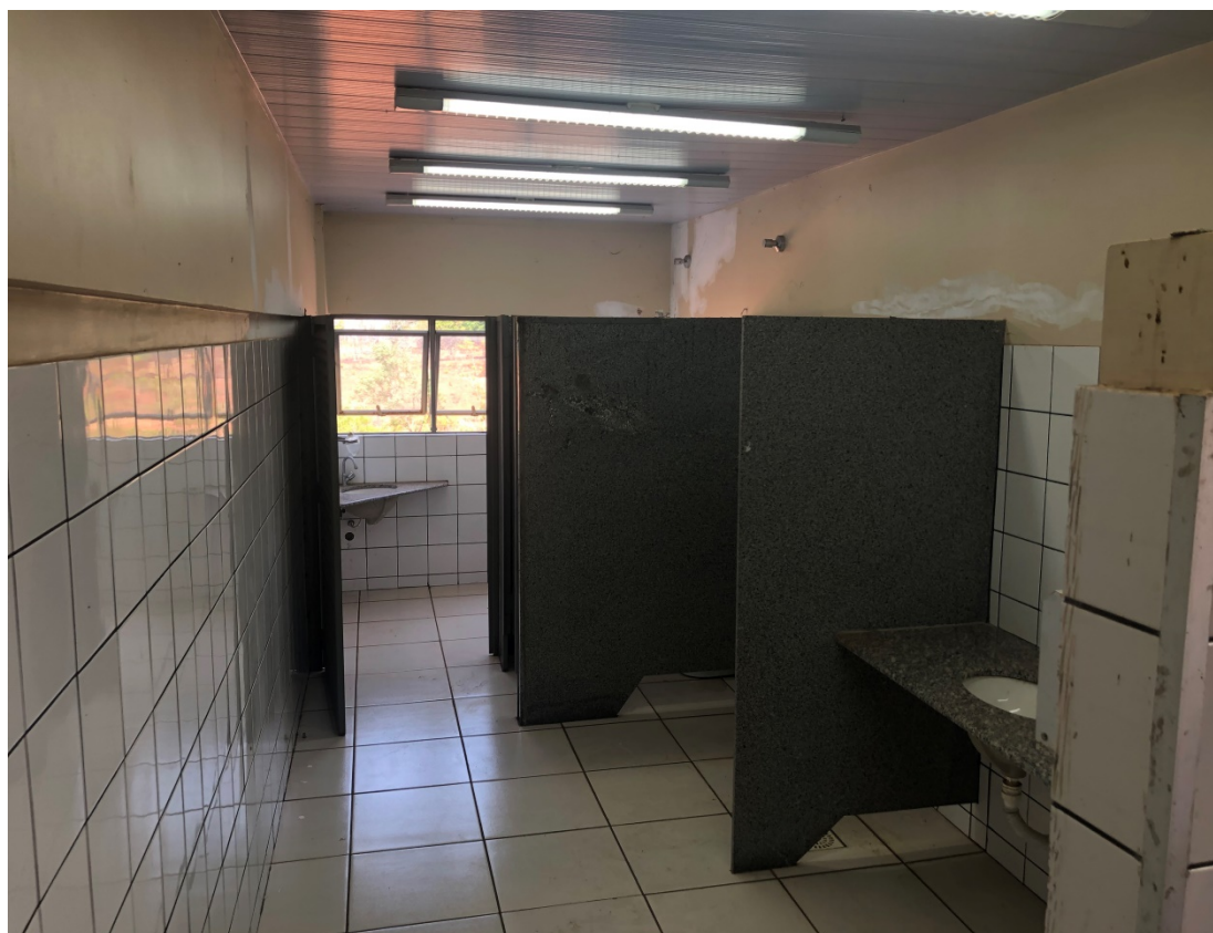
Foto 066: Vista geral banheiro masculino
