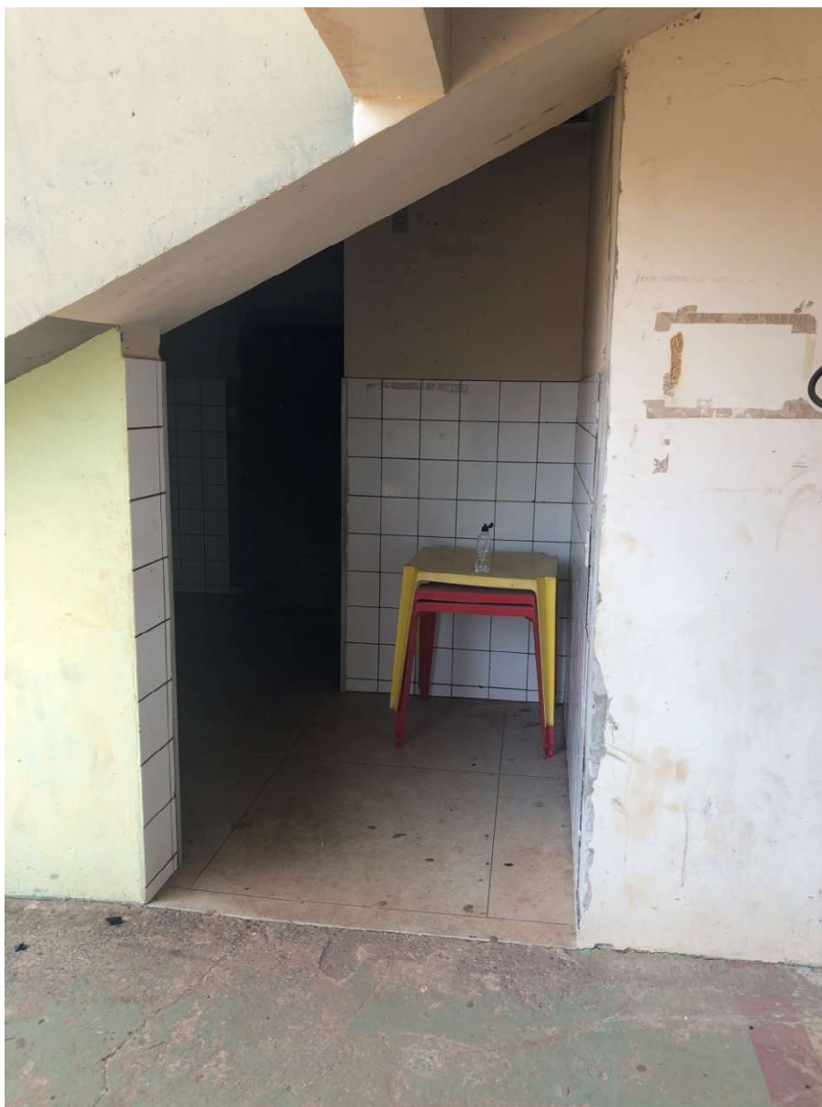
Foto 080: Vista entrada do banheiro
