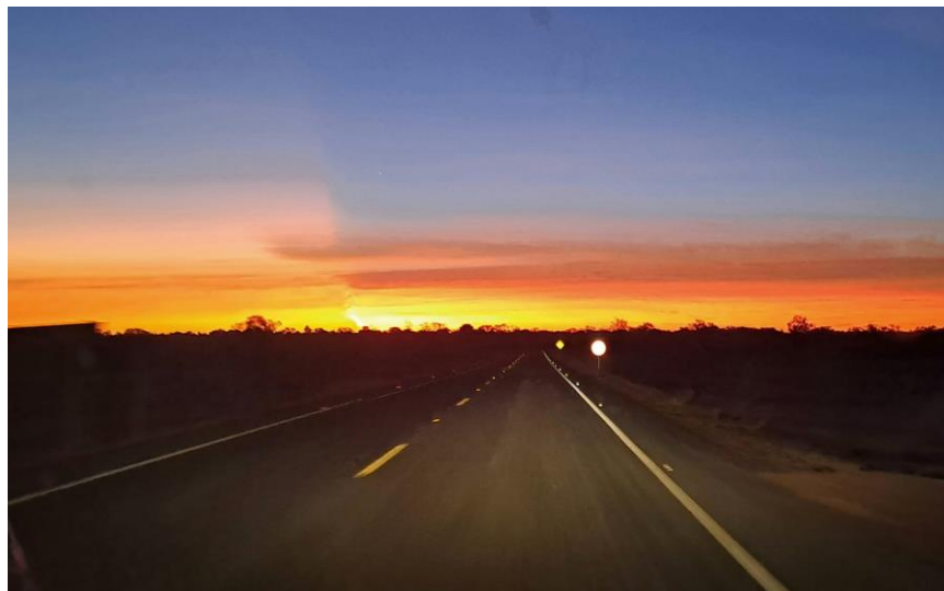
Pavimentação da Rodovia TO-247 – Lagoa do To ao km 50 (São Félix) Jalapão.
