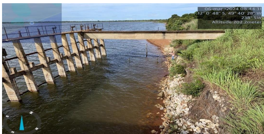
Vista da tomada d'água da Barragem Taboca I, e do talude, margem esquerda da estrada.
