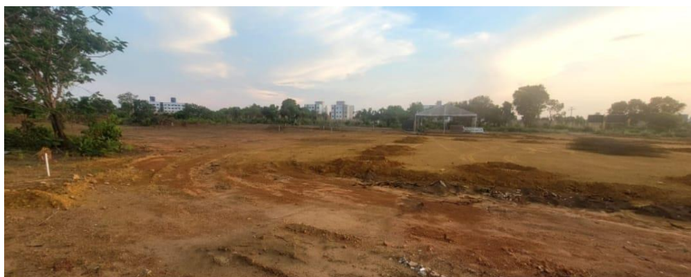
Início dos trabalhos de obras para construção de 176 unidades habitacionais na quadra ARSO 92 em Palmas TO. Captação de Recursos no valor total de 31 milhões.
