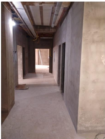
Imagem 03: Execução da Obra de construção do bloco da Maternidade no Hospital Regional de Augustinópolis.
