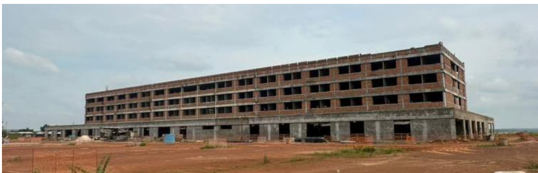
Imagem 01: Fachada Sul do bloco de internação do Hospital Geral de Araguaína – HGA
