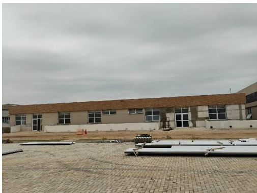
Imagem 04: Fachada Norte (Bloco do Ambulatório) do HGA
