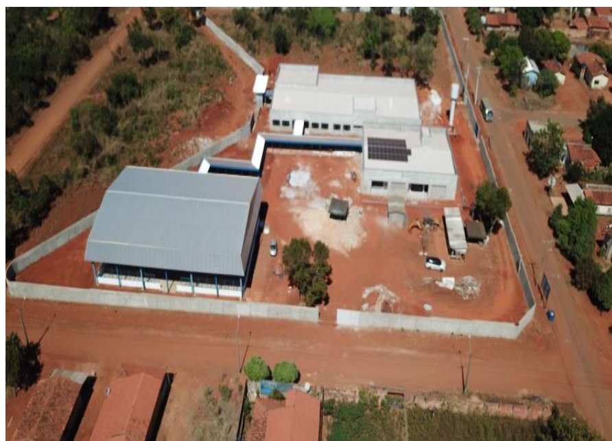
Colégio Militar do Estado do Tocantins – Jorge Humberto Camargo – CAIC e Construção de prédio escolar no distrito de Buritirana em Palmas.
