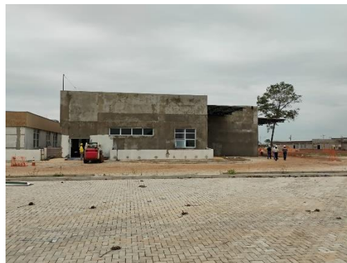
Imagem 05: Fachada Norte (Bloco do Necrotério) do HGA
