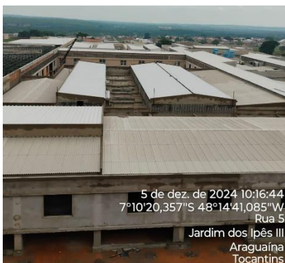
Imagem 06: Execução da Cobertura do HGA
