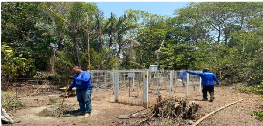
Instalação de Plataforma de Coleta de Dados na Bacia Hidrográfica do Rio Formoso
