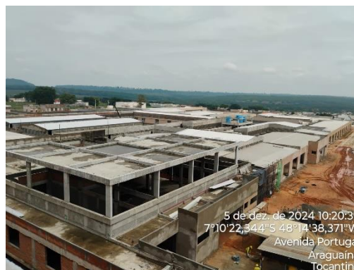
Imagem 07: Execução da Cobertura do HGA
