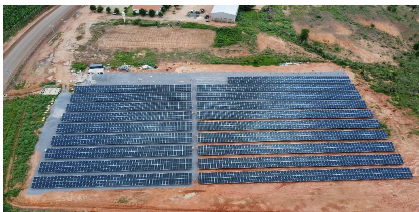
Vista aérea da Usina Fotovoltaica, Projeto Manuel Alves.
