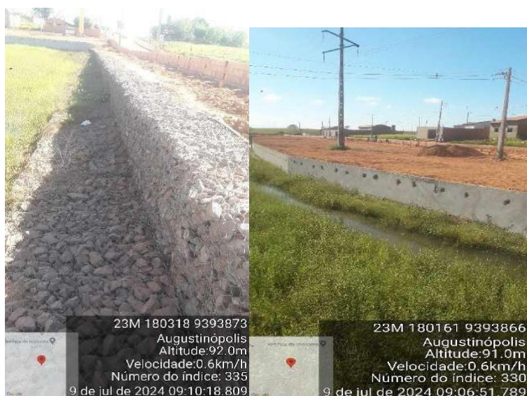
Figura 1: Obra Finalizada: Construção do Muro de Contenção de Aterro do Balneário – Augustinópolis – TO
