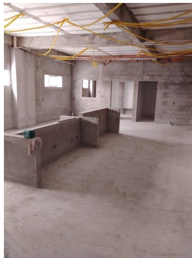
Imagem 04: Execução da Obra de construção do bloco da Maternidade no Hospital Regional de Augustinópolis.
