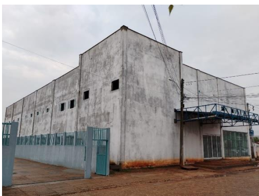
Imagem 01: Execução da Obra de construção do bloco da Maternidade no Hospital Regional de Augustinópolis
