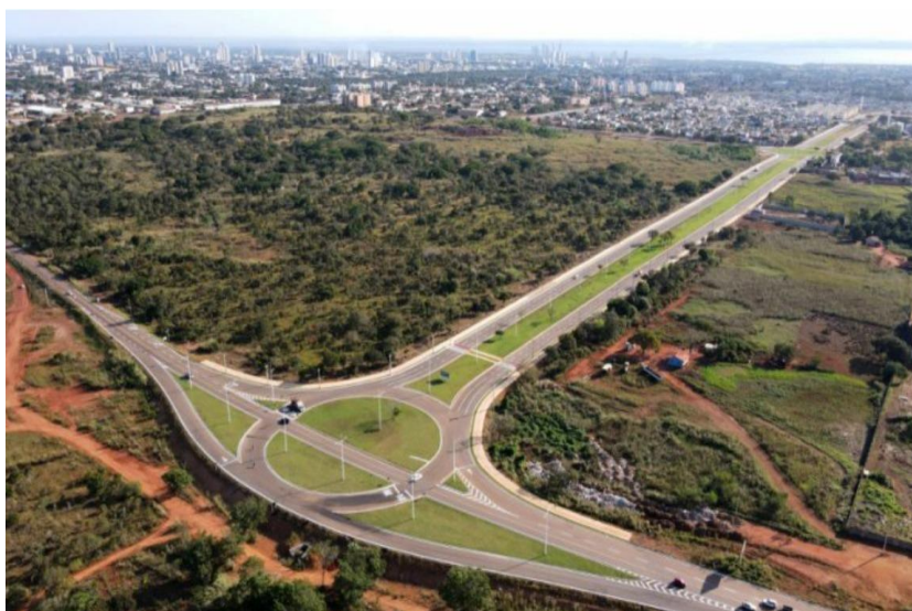
Conclusão da Avenida NS-15.
