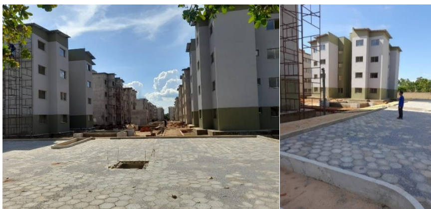
Construção de 272 unidades habitacionais na Quadra ARSO 92 em andamento.
