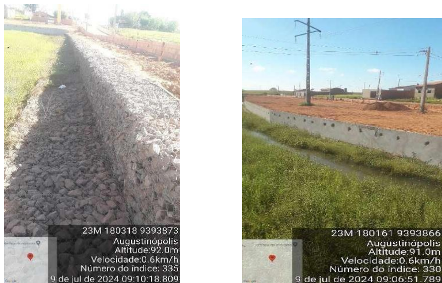
Figura 1: Obra Finalizada: Construção do Muro de Contenção de Aterro do Balneário – Augustinópolis – TO
