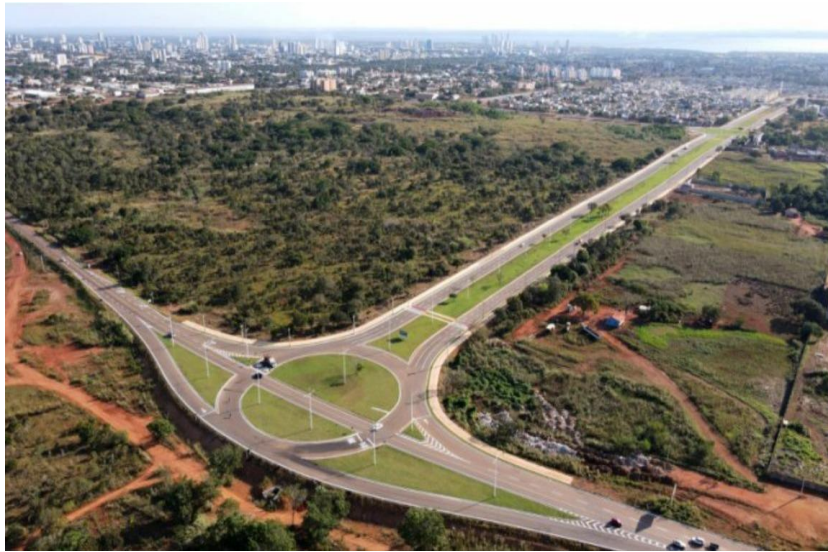
Conclusão da Avenida NS-15.
