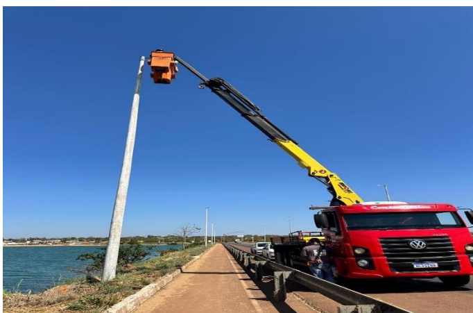
Manutenção de iluminação da Ponte Governador Siqueira Campos
