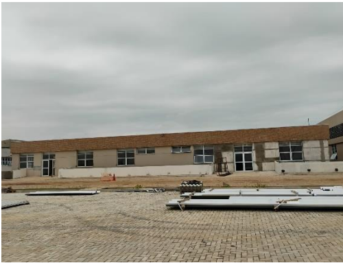
Imagem 04: Fachada Norte (Bloco do Ambulatório) do HGA
