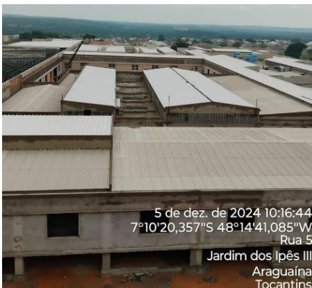
Imagem 06: Execução da Cobertura do HGA
