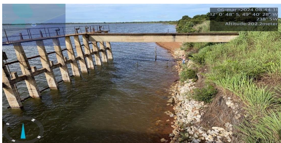
Vista da tomada d'água da Barragem Taboca I, e do talude, margem esquerda da estrada.
