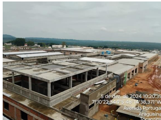
Imagem 07: Execução da Cobertura do HGA
