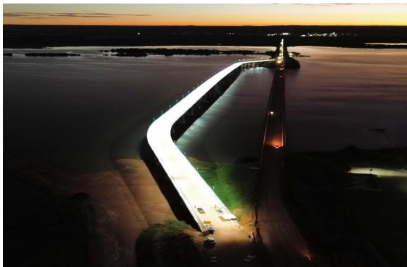
Ponte sobre o Rio Tocantins em Porto Nacional – Rodovia TO-255.
