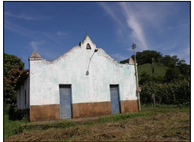
FOTO 3.5.1.12 – Igreja situada próxima ao local do barramento do eixo R-05.
