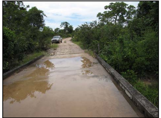
FOTO 3.5.1.33 Vista da ponte sobre o Rio Bezerra no eixo R-10.
