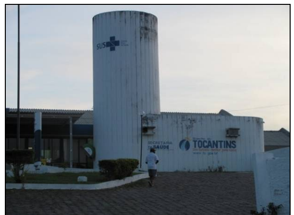
FOTO 4.4.1.26 - Hospital Regional de Arraias/TO
