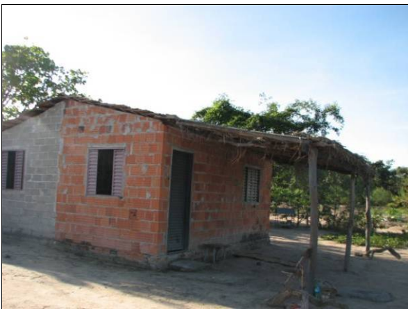
FOTO 4.4.1.51 - Local de moradia - ADA - Arraias.
