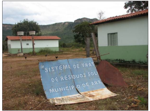
FOTO 4.4.1.12 - Aterro sanitário construído em Arraias e inoperante.
