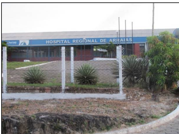
FOTO 4.4.1.25 - Hospital Regional de Arraias/TO
