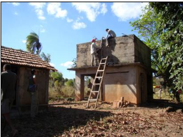
FOTO 4.2.3.5 - Vista parcial do ponto SB 3.
