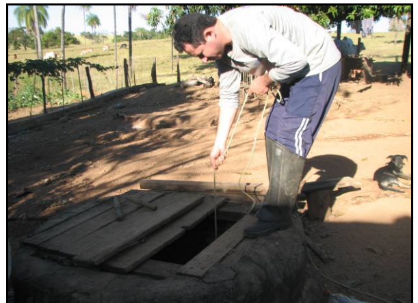
FOTO 4.2.3.2 - Vista parcial do ponto SB 1.
