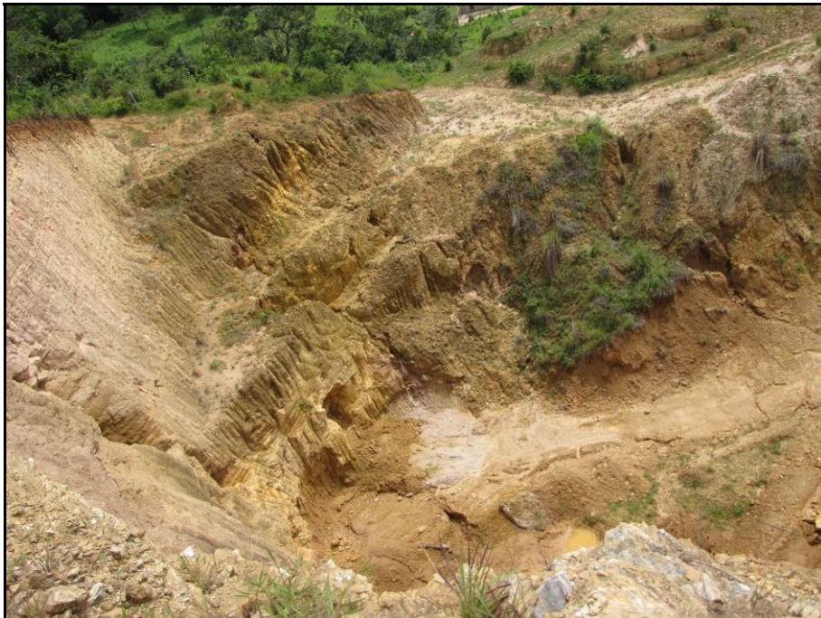
FOTO 4.2.4.32 – Trecho de antiga lavra abandonada nas proximidades das áreas prevista para lavra. Observar os taludes com alto grau de declividade.
