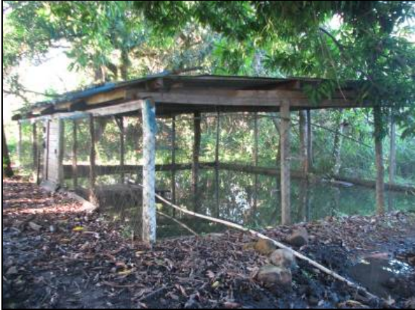
FOTO 4.2.3.3 - Vista parcial do ponto SB 2.
