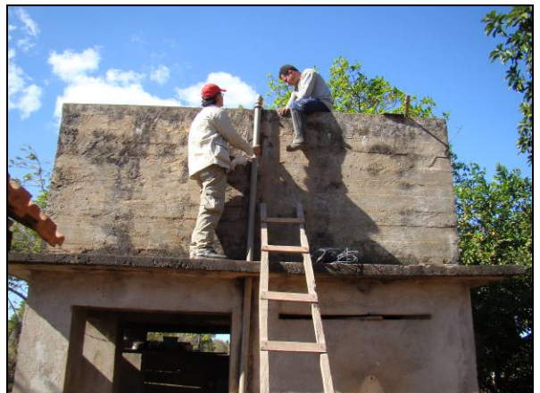
FOTO 4.2.3.6 - Vista parcial do ponto SB 3.
