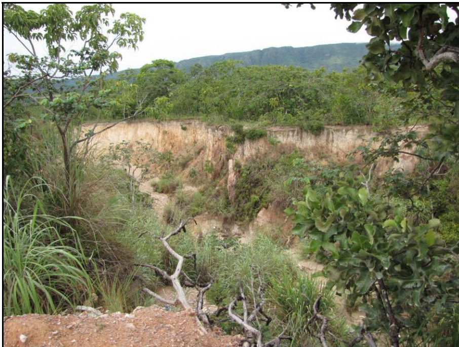
FOTO 4.2.4.34 – Vista de grande feição erosiva na área de estudo, onde se desenvolve uma grande voçoroca. Foi possível observar a interceptação do lençol freático, característica dos processos de voçorocamento.
