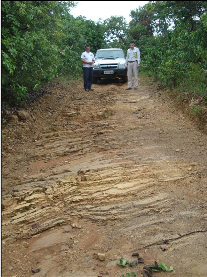
FOTO 4.2.4.10 – Vista do piso do pediplano do Tocantins, na região de Arraias. Observar o afloramento em camadas superpostas de siltitos, característicos do Grupo Bambuí.
