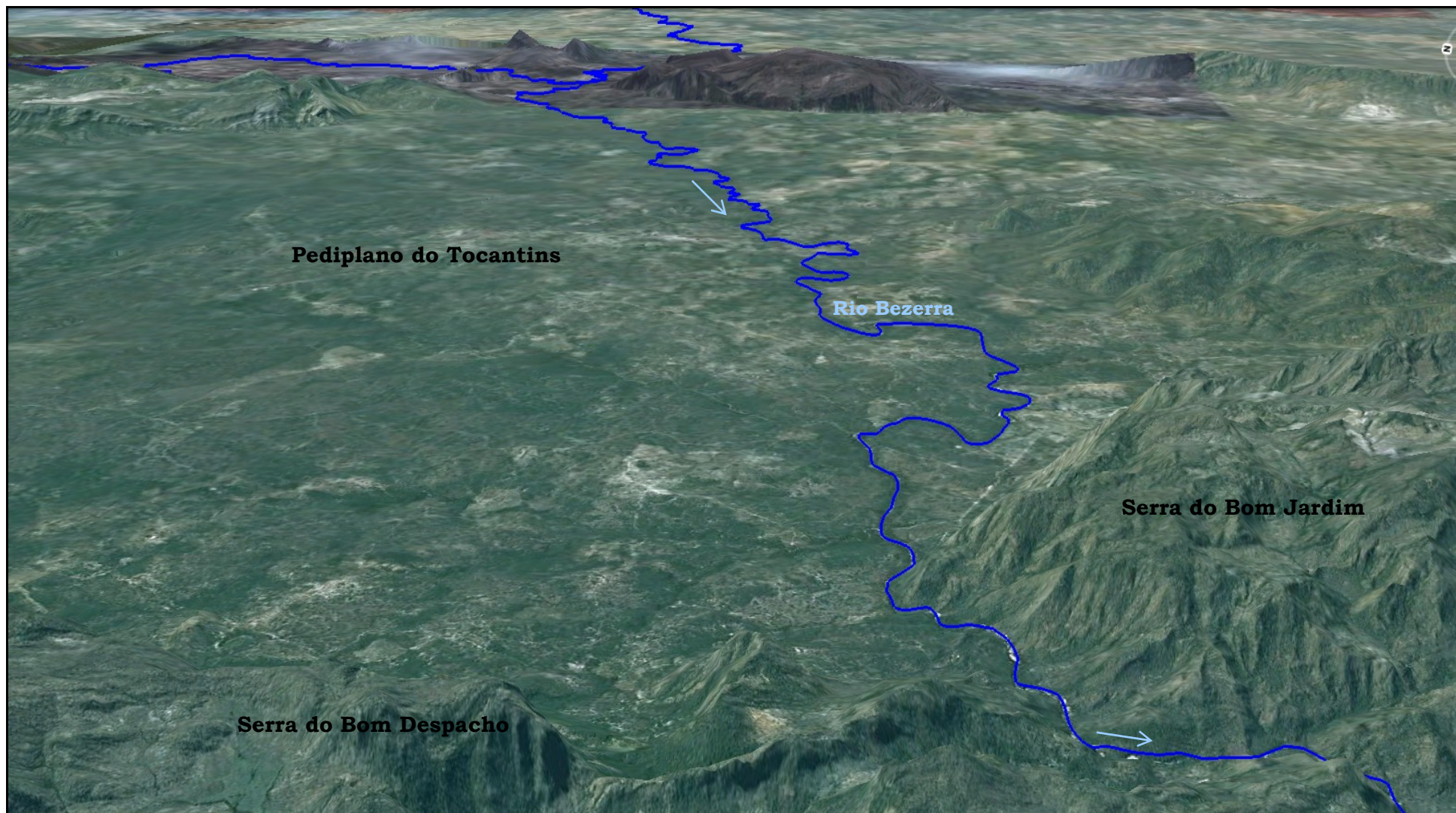
FIGURA 4.2.4.14 – Observa-se grande área pediplanada drenada pelo rio Bezerra. As estruturas mais proeminentes são sustentadas por serras quartzíticas. Ao fundo é possível notar as áreas das cabeceiras, a norte o rio Bezerra com as nascentes nas serras de Arraias e Chapadão dos Negros e a leste o rio Montes Claros, principal afluente do rio Bezerra com suas nascentes nos arredores do Chapadão Ocidental, nas proximidades da divisa entre os estados de Goiás e Bahia.
