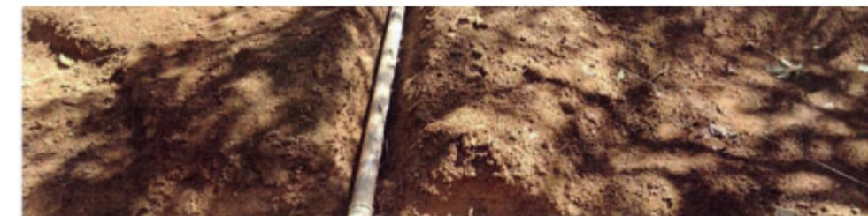
2º Passo - Escavação da drenagem (cano de 100 mm).
