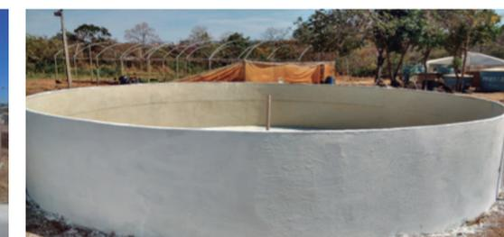
6º Passo - Retire o madeirite e deixe secar por 12 horas e encha de água
