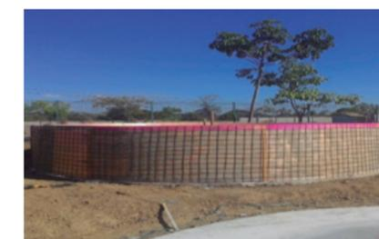
5º Passo - Posicionamento do madeirite e aplicação do cimento.
