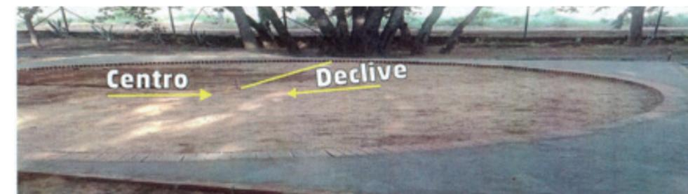
3º Passo - Nivelamento do local, onde será feito o contra piso em forma de funil. O afunilamento deve ser feito colocando uma queda de 10 cm do entorno para o centro do tanque.
