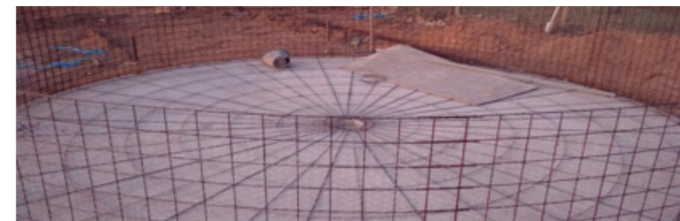
4º Passo - Marcar e posicionar as estruturas de telas no fundo e nas laterais.
